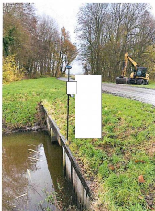
Beton bovenkant duiker
