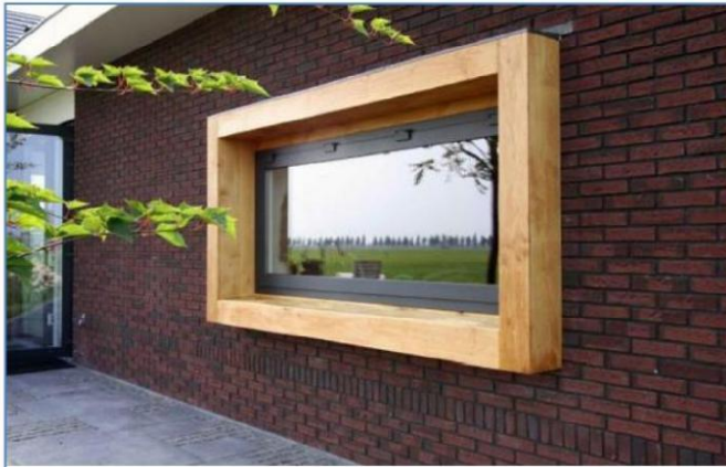
Kader rondom kozijn voorgevel
