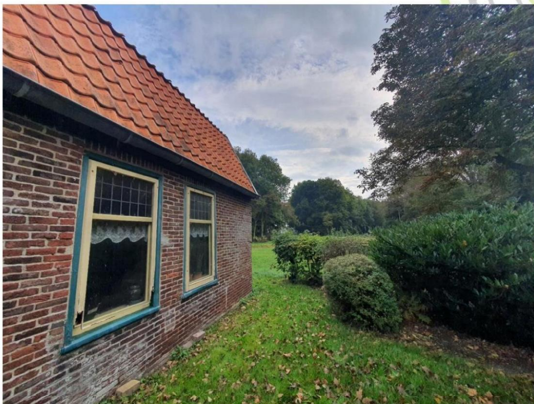
Zijkant van de te slopen woning.
