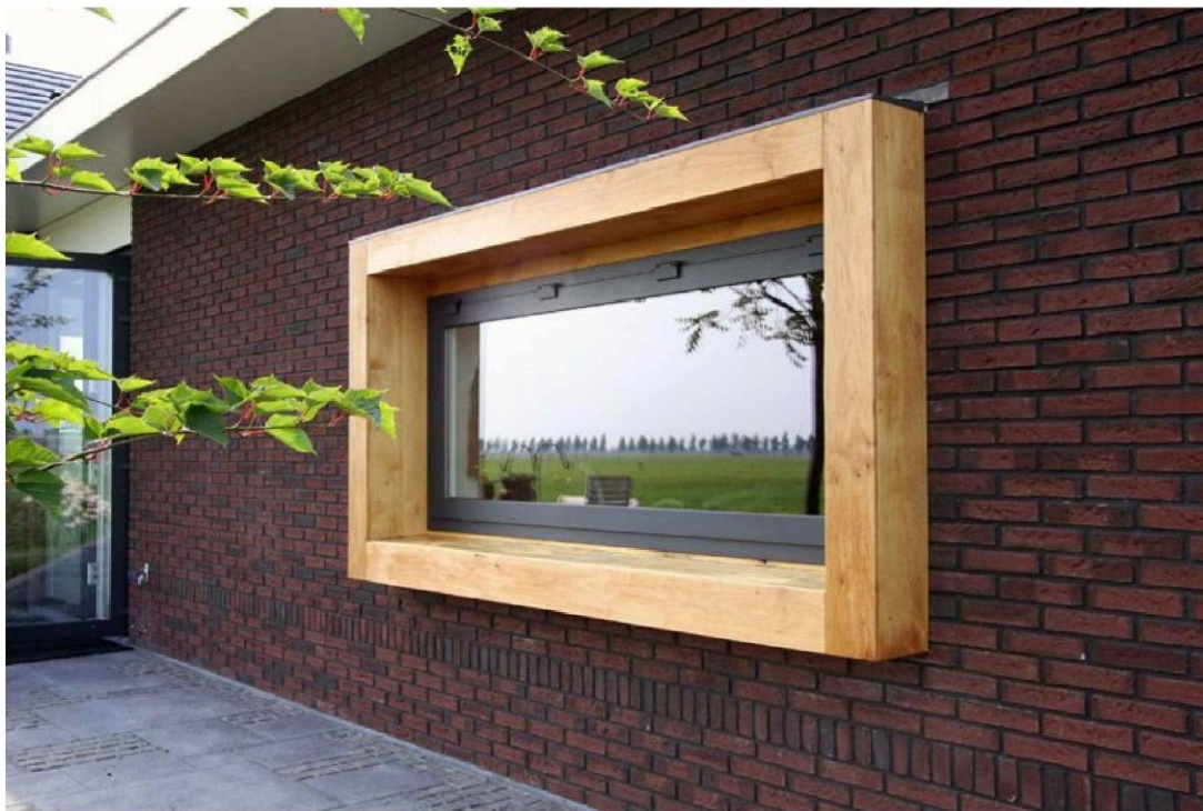
Kader rondom kozijn voorgevel
