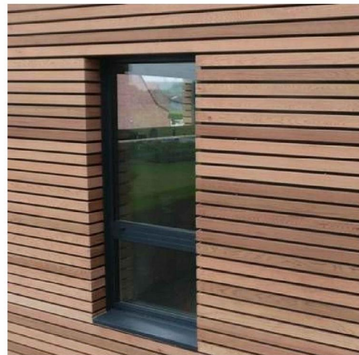
Uitkraging hoek gevel
