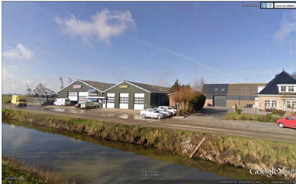
Afbeelding 2: De opvallende manier waarop de bebouwing is gesitueerd. Rechts het woonhuis dat zoals gebruikelijk georiënteerd is op de hoofdontginningsas terwijl de achterliggende schuren op de Barsingerweg georiënteerd zijn.
