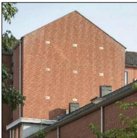
Afb 19 + 20: Gierzwaluwkasten ingemetseld (worden ook gebruikt door Huismussen)
