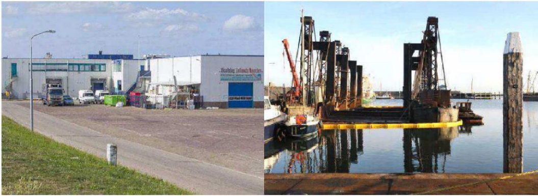
Figuur 4: Bedrijven in de haven van Den Oever met links de visafslag en rechts de schepenlift van Luyt Groep
