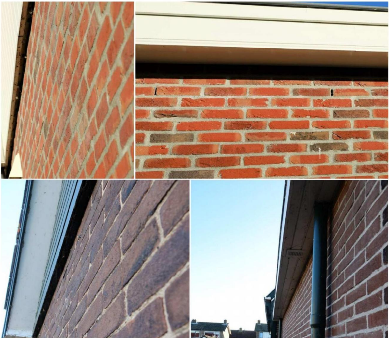
Figuur 3. Aanpalende dakranden en geveldelen niet toegankelijk voor vleermuizen.
