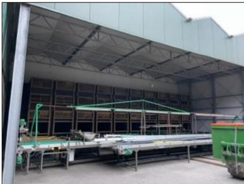
Afb 8: Droogruimte, open kap
