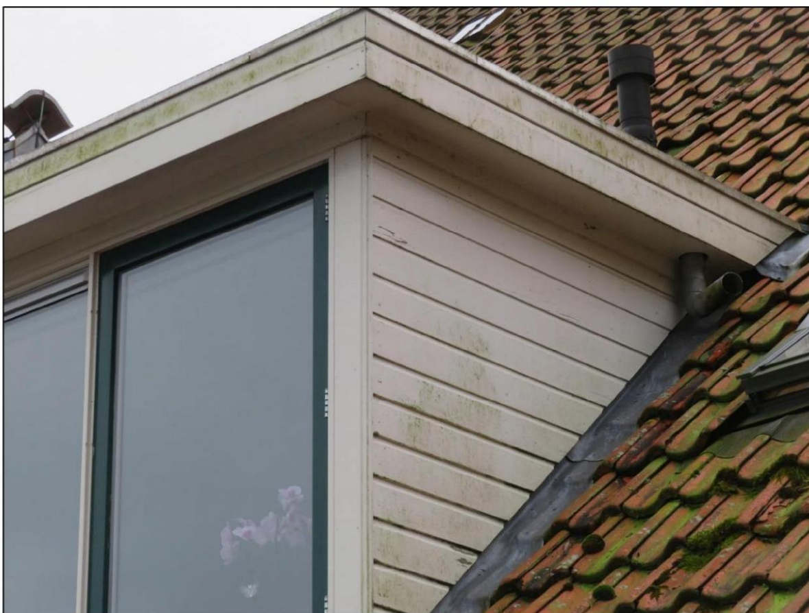
Afb 11: Dakkapellen hebben geen naden en kieren welke gebruikt kunnen worden door vogels om in- en uit te vliegen
