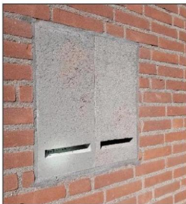
Afb 8: Inbouw vleermuiskast
