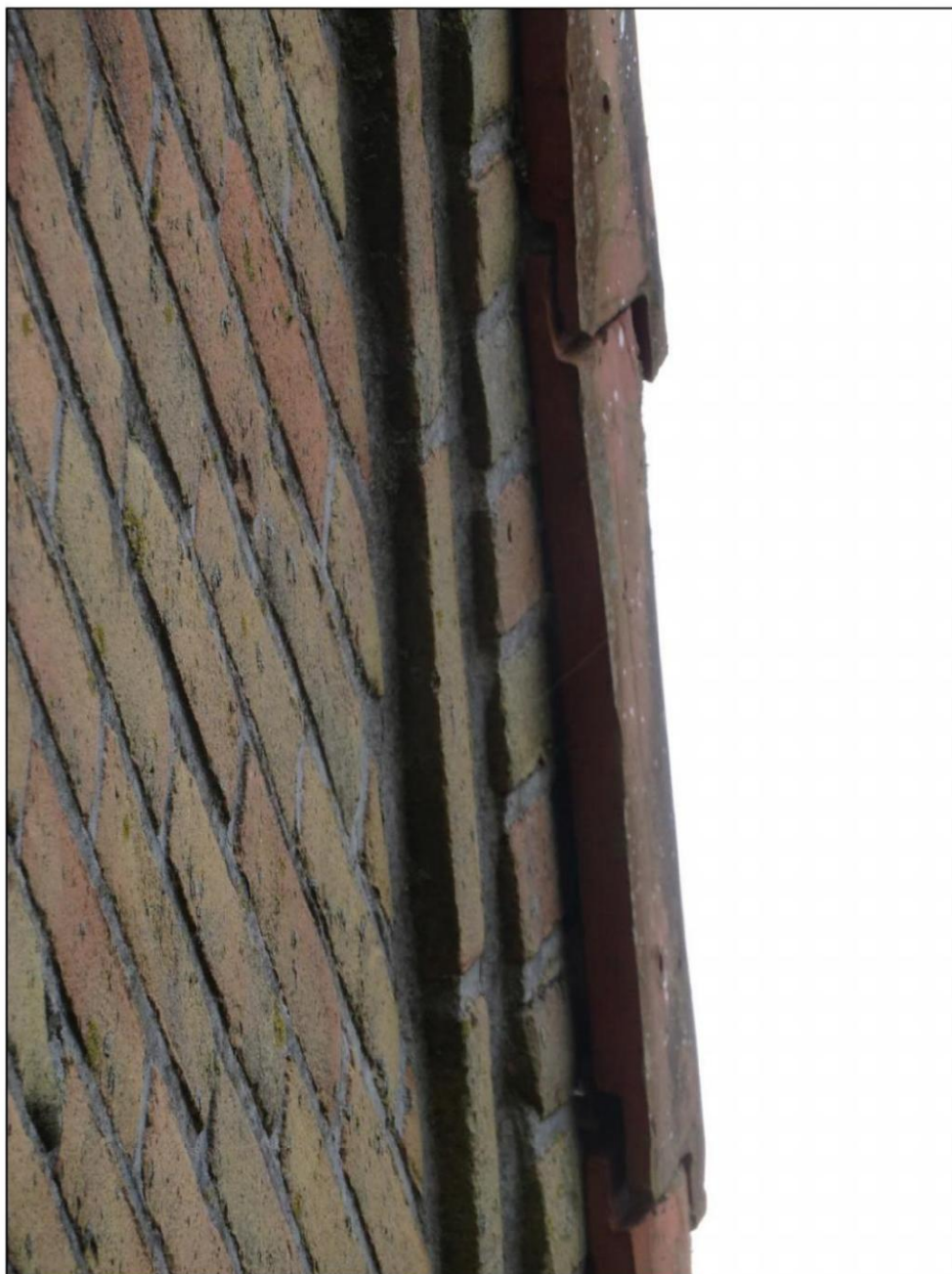
Afb 14: Kantpannen sluiten strak aan op de gevels
