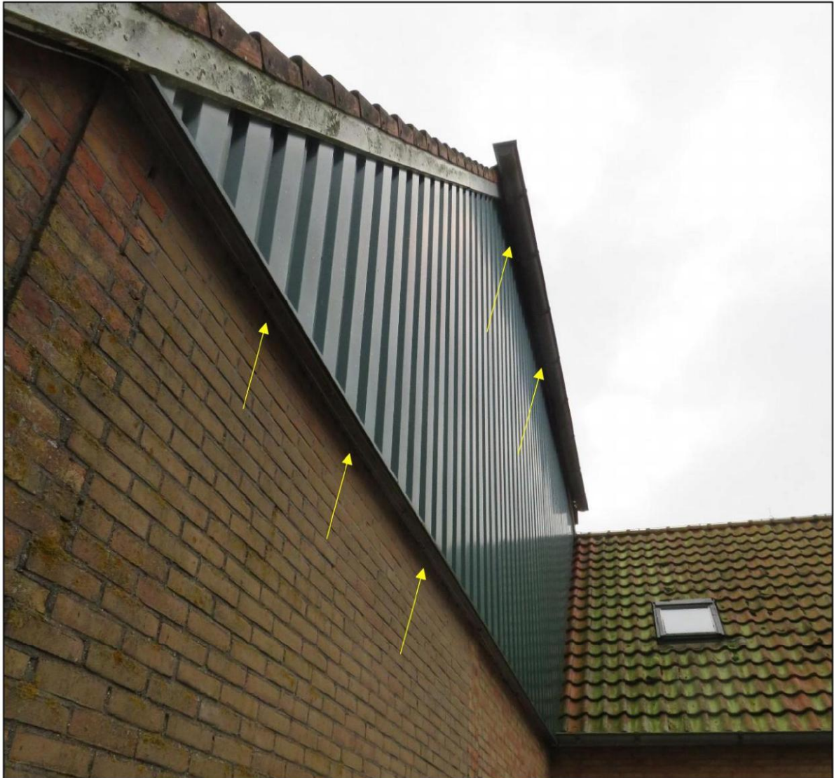
Afb 15: Diverse mogelijkheden voor vleermuizen om in- en uit te vliegen. Kantpannen sluiten strak aan op windveer
