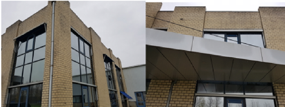
Afbeelding 2 en 3. Het pand met de open stootvoegen boven de ramen
