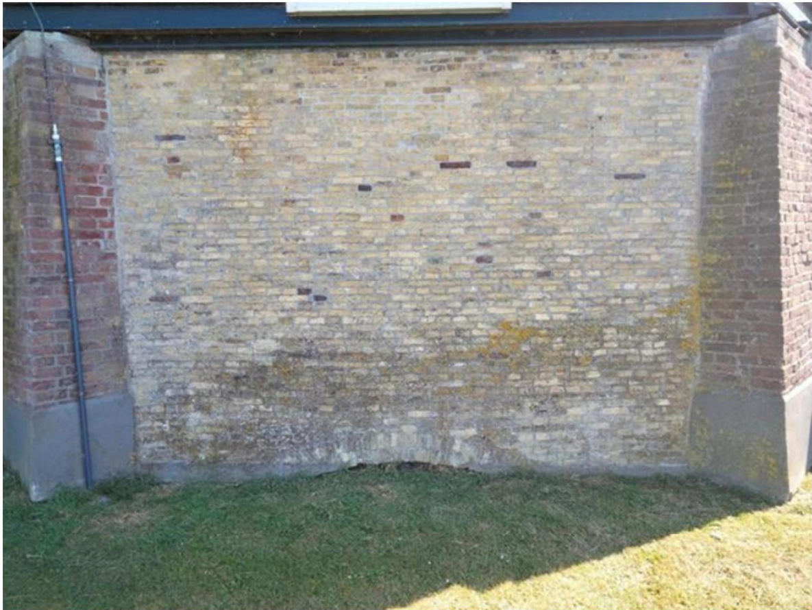
Afb. 26, noordwestmuur uit secundair gebruikte ijsselsteentjes. Grondboog.
