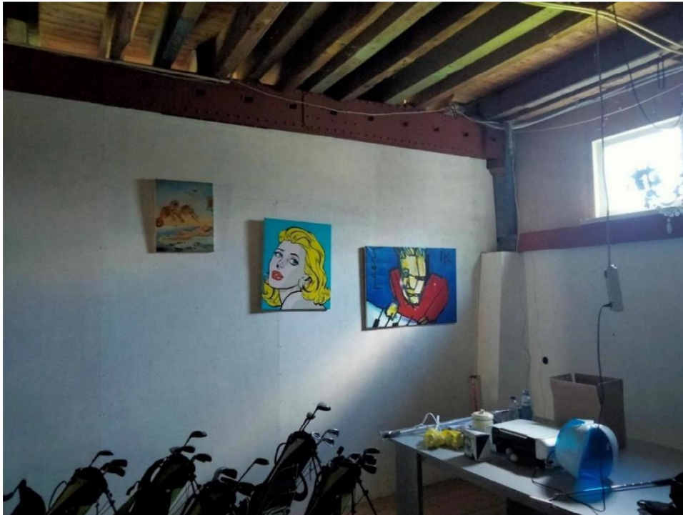
Afb. 31, middenruimte naar het NW, niveau 0-0.1-3. De ijzeren moerbalk rust op de muur.
