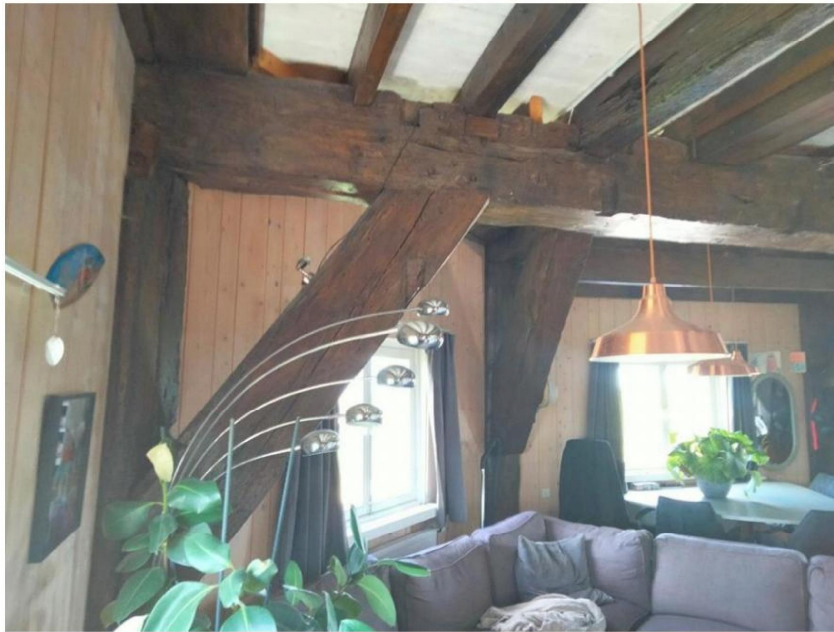
Afb. 37, woonruimte in het onderchtkant (niveau 2-3) naar het noorden.
