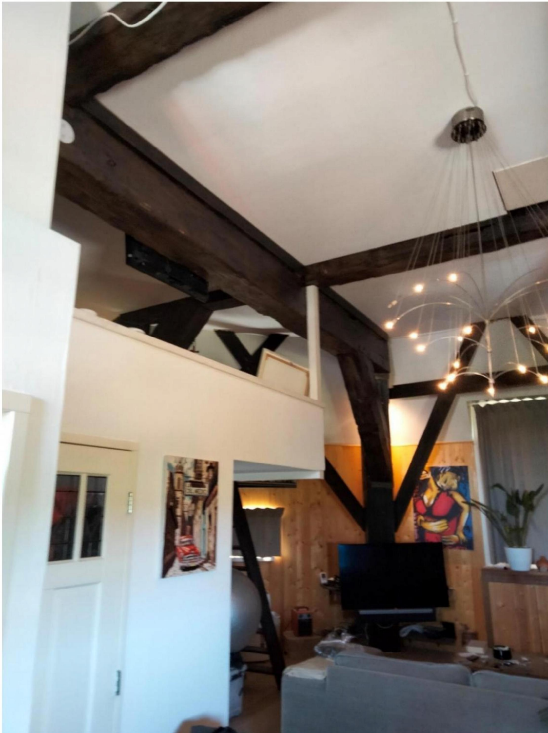
Afb. 45, de woonruimte bij de niveaus 3,4 en 5, cq. 5, naar het westen gezien. Ongeveer 1 meter boven de vloer bevond zich de stelling.
