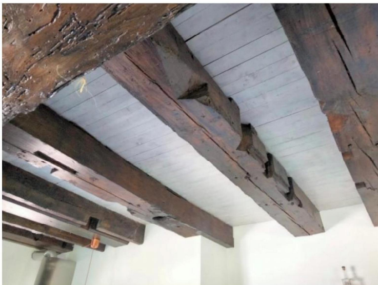
Afb. 43, zoldering op niveau 5, bouwsporen.
