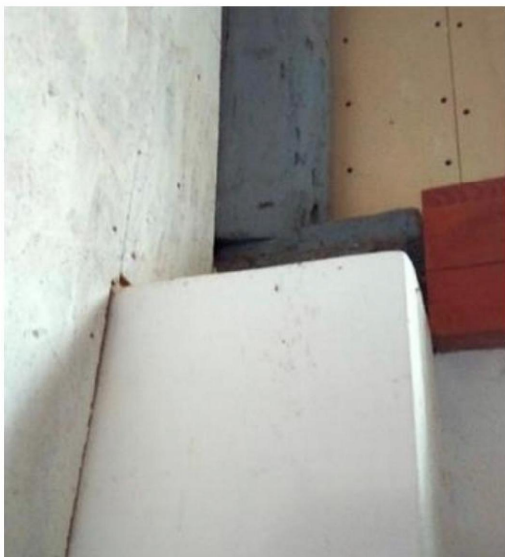
Afb. 35, noordwesthoek middenruimte, niveau 1.
