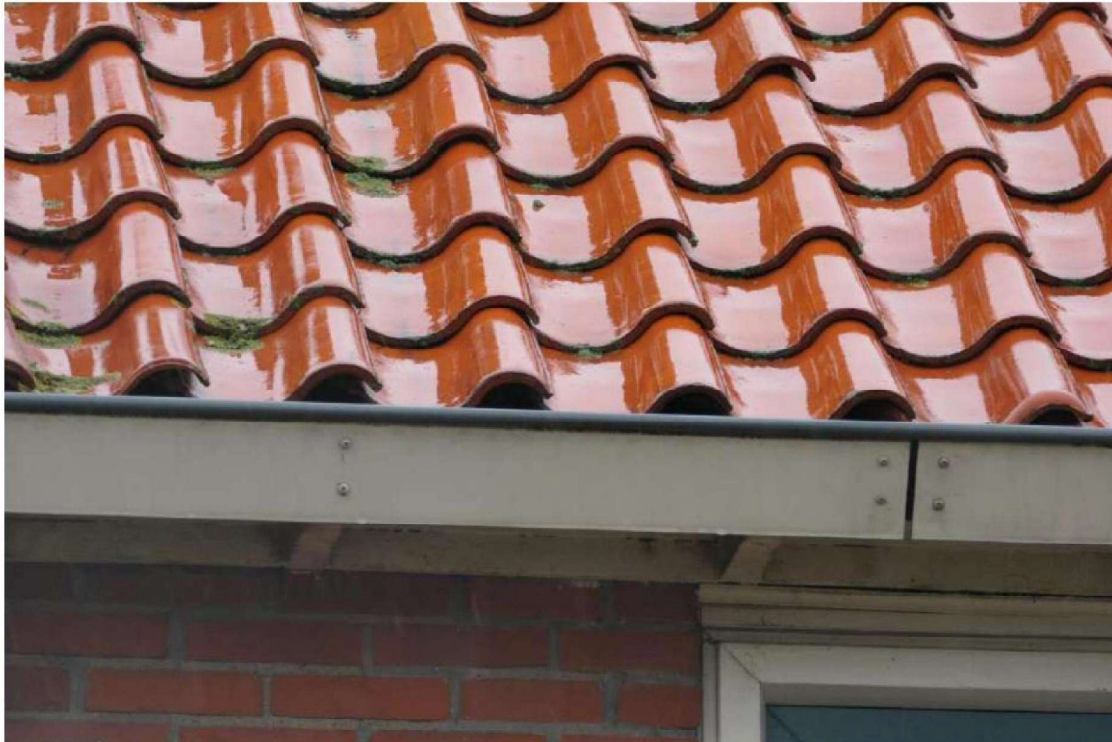
Figuur 4.1 De daklaag is via de eerste rij dakpannen toegankelijk voor huismussen.
