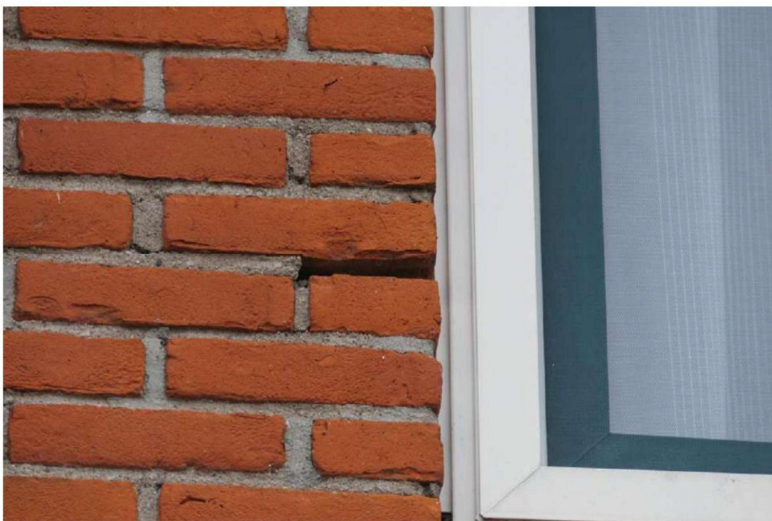
Figuur 4.7 Rond de raamkozijnen zijn bij sommige woningen openingen in de gevel aanwezig, deze kunnen toegang tot de spouwmuur bieden.
