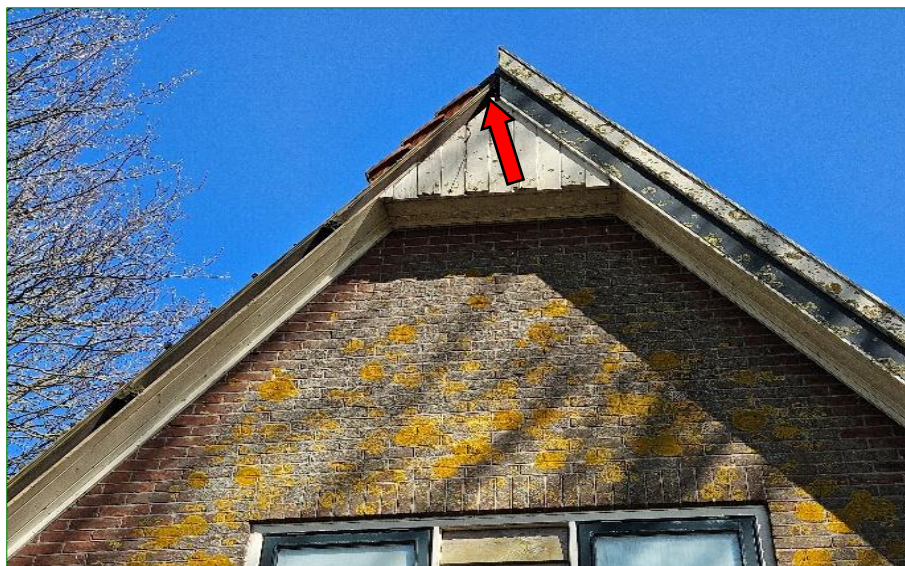
Openingen zoals onder de boeidelen aan de kopse kanten van de bebouwing (rode pijlen) geven mogelijk toegang tot voor Gierzwaluw geschikte achterliggende ruimtes.
