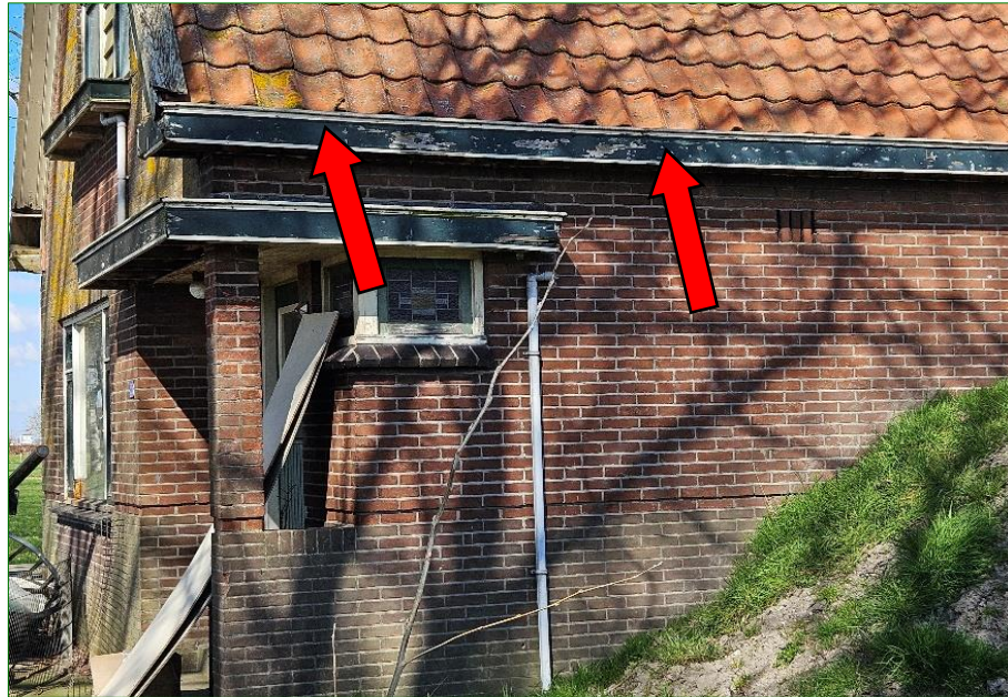
Openingen onder de dakpannen (rode pijlen) van de bebouwing geven mogelijk toegang tot voor Huismus geschikte achterliggende ruimtes.
