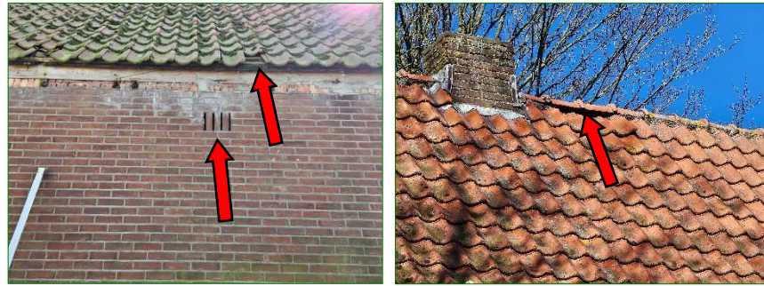
Openingen in de bebouwing en het ventilatiesysteem (rode pijlen) van de bebouwing geven mogelijk toegang tot voor vleermuizen geschikte achterliggende ruimtes.
