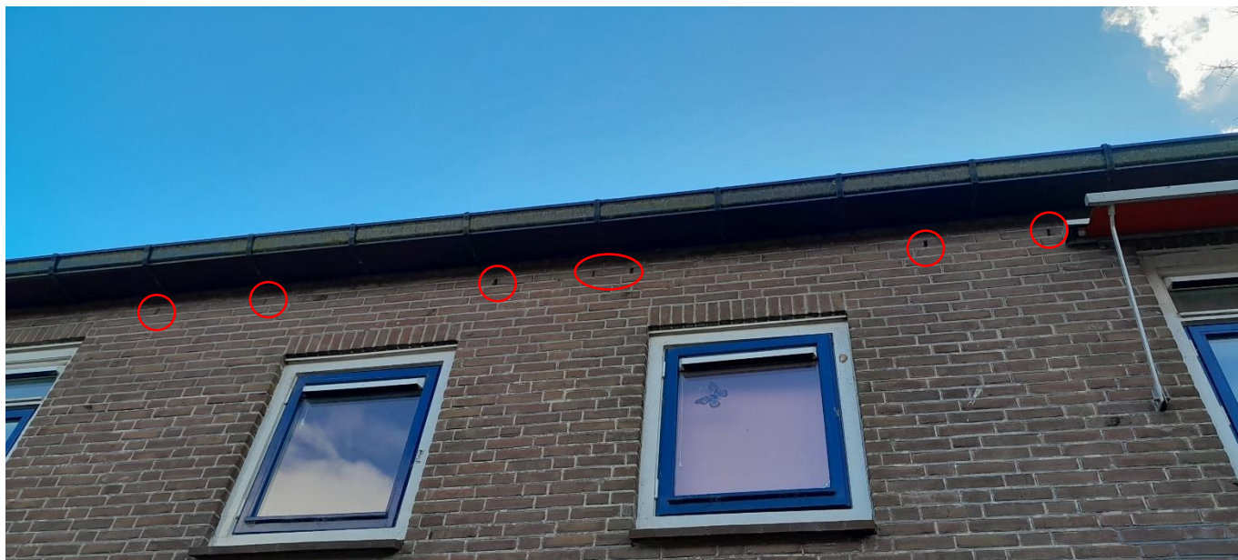
Open spouw-gaten (rood omrand) vlak onder de dakrand. Deze zijn wijd verspreid over het plangebied.
