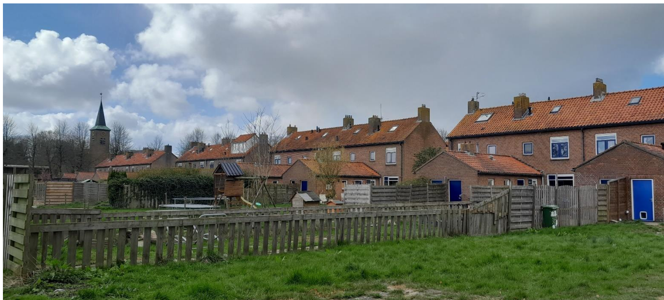
Representatief aanzicht van een deel van de achterkant van de rijtjeshuizen aan de zuidkant van de Torenstraat. De dakgoten en de daarin overlopende dakranden zijn geschikt voor broedvogels zoals huismussen en spreeuwen.
