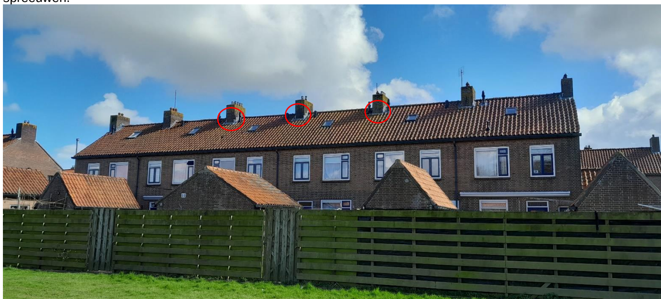
Representatief aanzicht van een deel van de achterkant van de rijtjeshuizen aan de noordkant van de Torenstraat. Bij de schoorstenen zijn losse loodflappen te zien waar o.a. gierzwaluwen in kunnen vliegen (voorbeelden zijn rood omrand).
