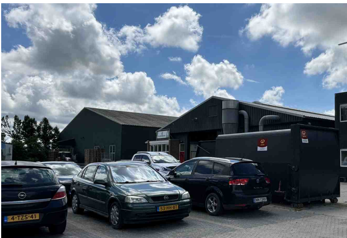
Afb. 5: Voorkant van bedrijfspanden waar golfplaten dak en gevel structuur te zien is.
