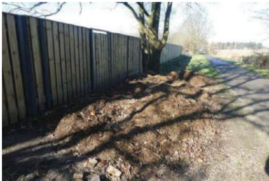
Zicht vanaf het fietspad aan de oostzijde.
