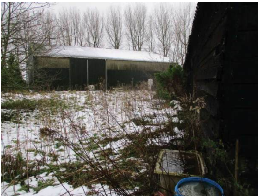
Onverhard terrein oostzijde achter schuur
