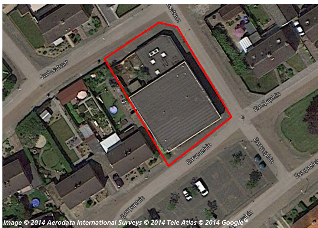
Afbeelding 1: Luchtfoto bestaande situatie plangebied
