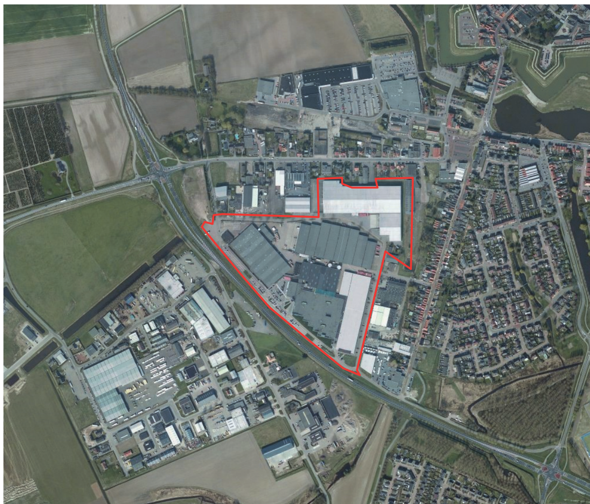
Figuur 1: Luchtfoto plangebied (bron: Bing Maps)
