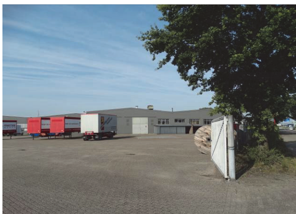
Figuur 7: Aanzicht magazijnen Tol-Morres en Opslag 7. Foto genomen vanaf de Industrieweg
