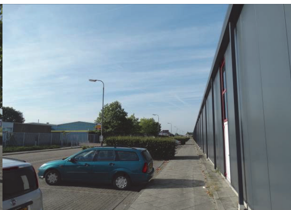
Figuur 4: Aanzicht parkeerplaatsen, groenstroken en magazijn van Morres. Foto genomen aan de Beneluxweg
