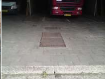
Olie-afscheider met slibvanger voorin de loods
