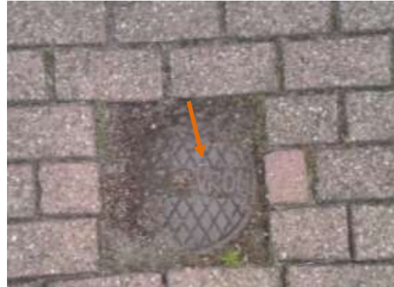
Putdeksel, controleput riool
