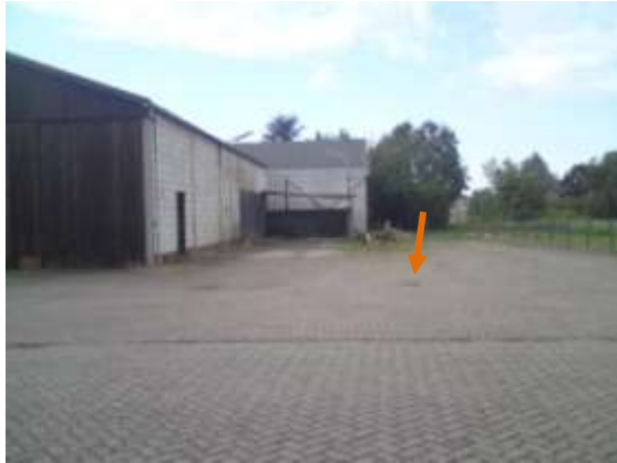
Putdeksel, controleput riool
