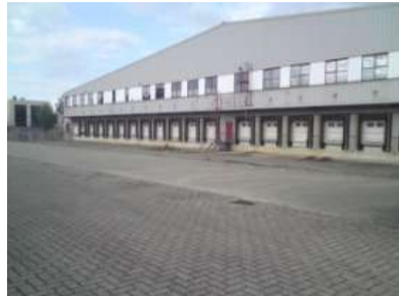
Westelijke gevel van Opslag 7 met de laadkluizen
