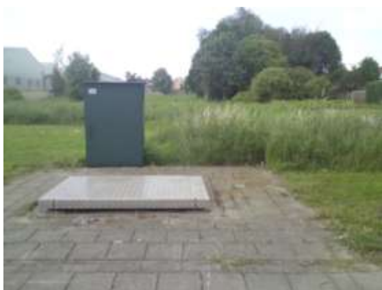
Gemaal tussen de vijver en de Industrieweg
