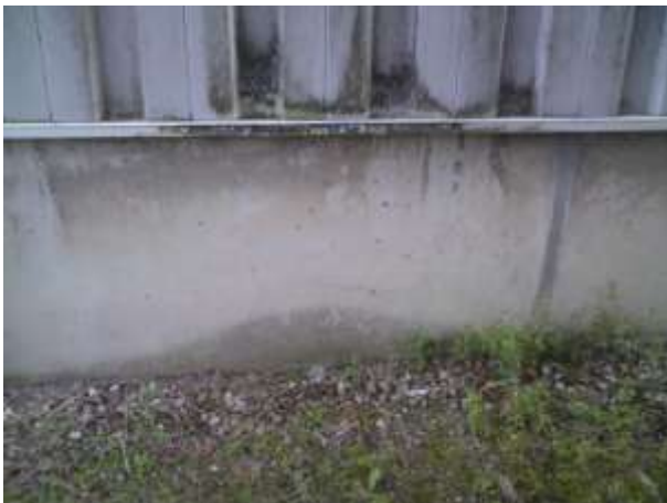
Tegen de achtergevel (noordzijde) van Depot 7 ligt over een breedte van circa 30 cm een strook met gebroken puin op het maaiveld
