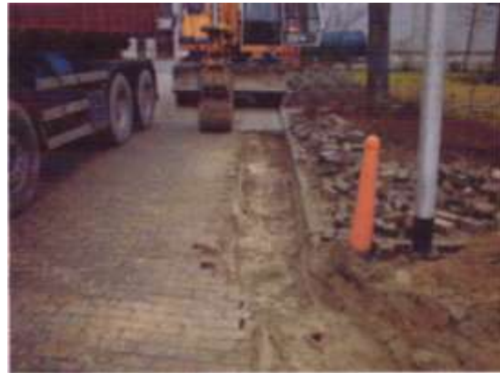
Ontgraving goot van de Industrieweg [Bron: Evaluatierapport "Grondsanering", Wematech, 4 april 2005]
