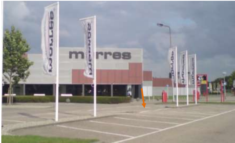
Locatie voormalig pompeiland (→)
