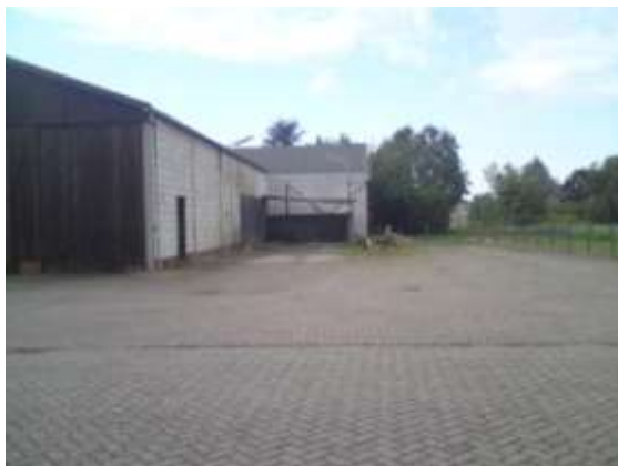
Schuur met op de achtergrond de loods van Transportbedrijf Dieleman-Leendertse B.V. Rechts van de schuur ligt een mestplaat met daarvoor een wasplaats. Het overige gedeelte van de verharding bestaat uit klinkers.
