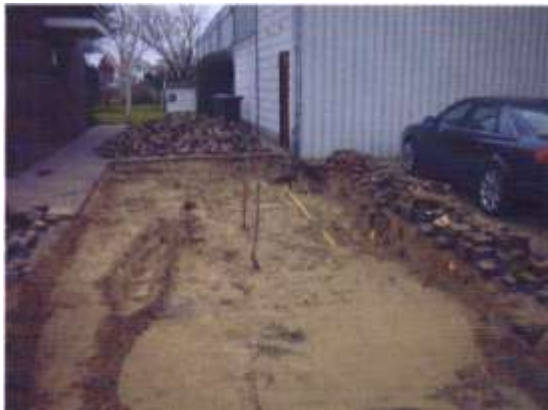
Ontgraving oprit tussen woning en loods [Bron: Evaluatierapport "Grondsanering", Wematech, 4 april 2005]
