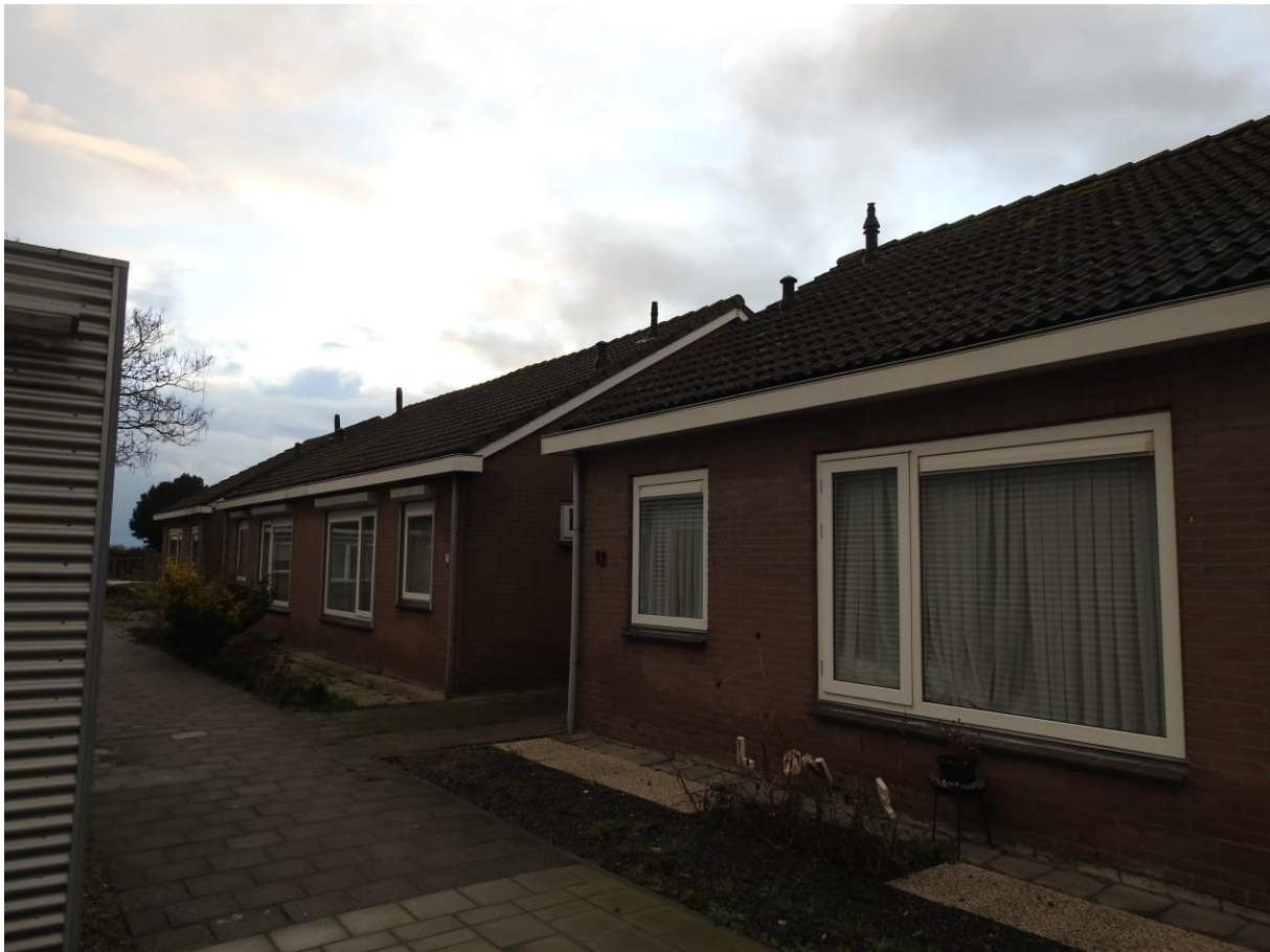
Foto 1 Te slopen huizen, pannendaken geschikt voor huismussen..
