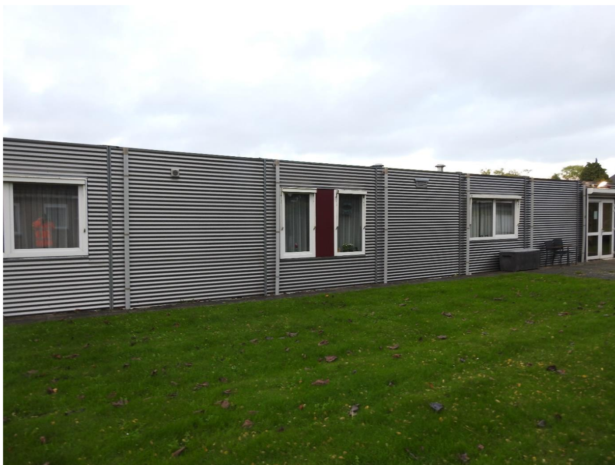
Foto 1. Te slopen bebouwing.
