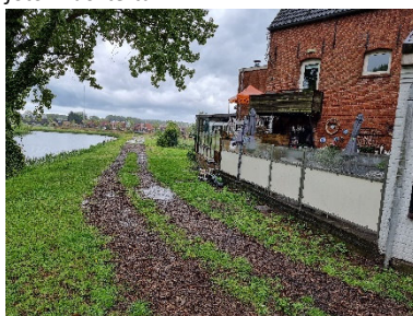
foto 5: noordzijde (toegangsweg behoort niet tot onderzoekslocatie)
