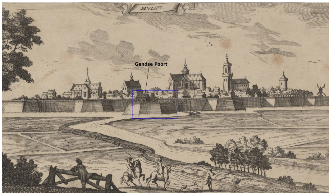
Figuur 22: Zicht op Hulst vanuit het zuiden, vermoedelijk vóór 1640 (Bouttats 1645).
