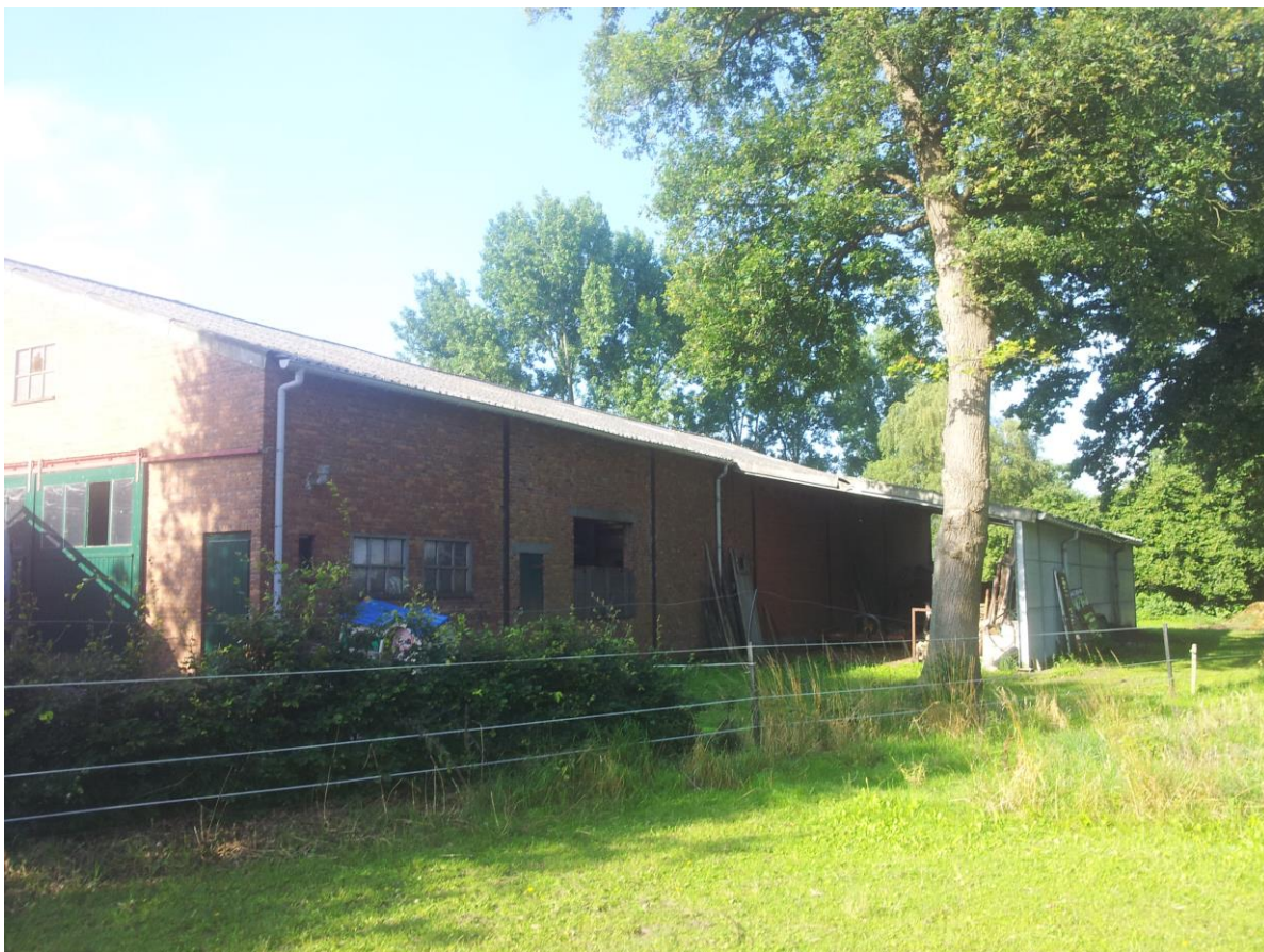
Figuur 2.6: Zij-aanzicht rechter gevel te slopen paardenstalling
