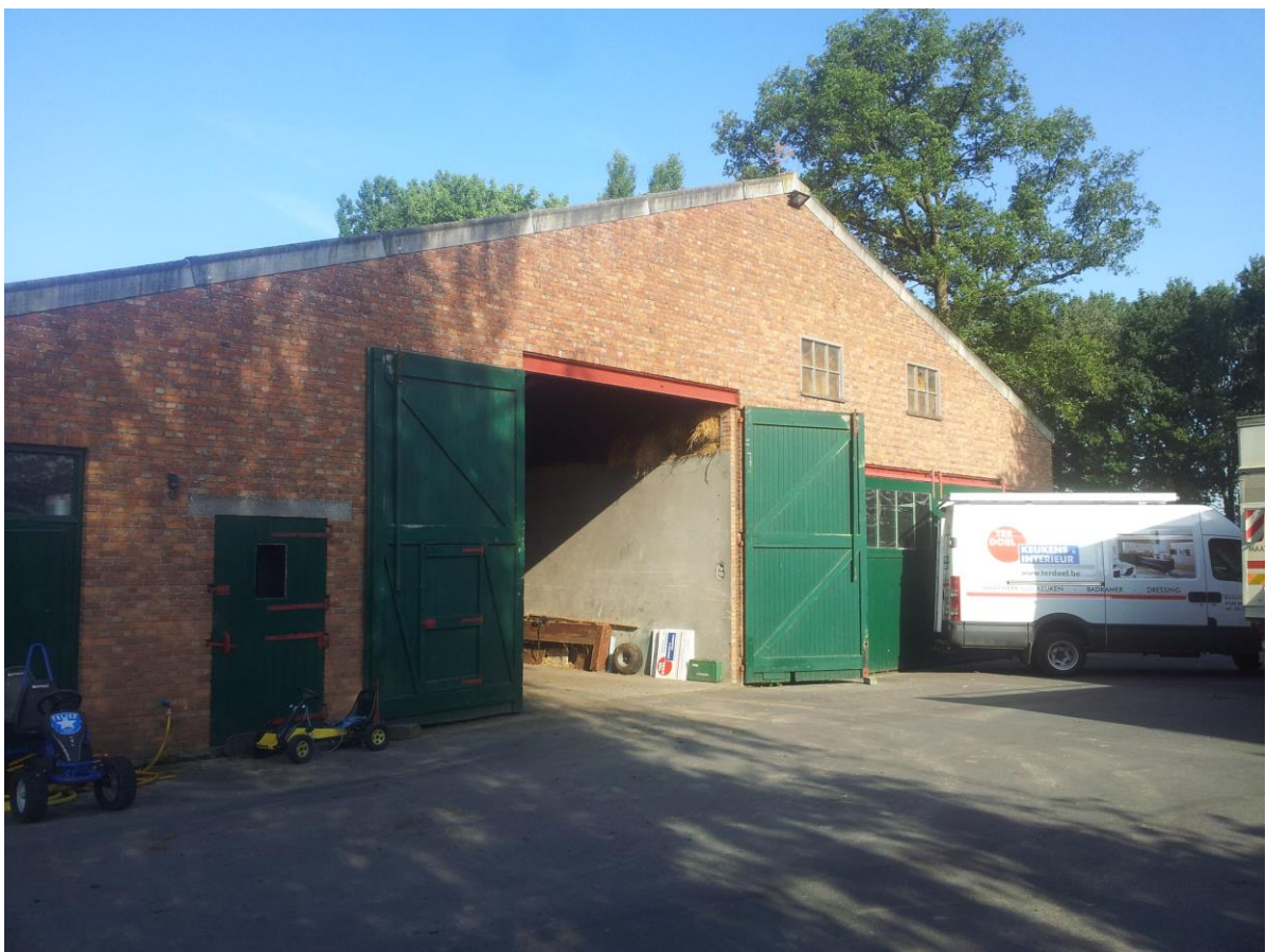
Figuur 2.4 Vooraanzicht te slopen paardenstalling
