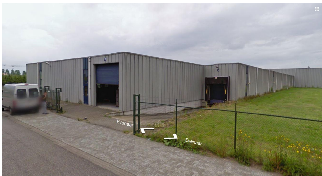
Bestaande bedrijfshal Evenaar 4 op 3,67 van de naar weg gekeerde perceelsgrens
