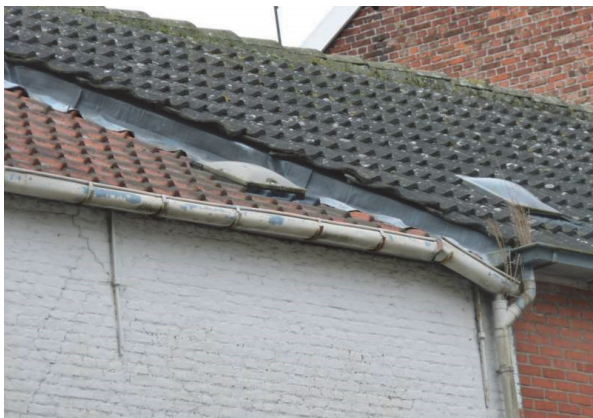
Fig. 7. Het dak van het te slopen bijgebouwtje heeft diverse ingangen, geschikt voor vleermuizen. Het dak is geschikt voor de huismus.
