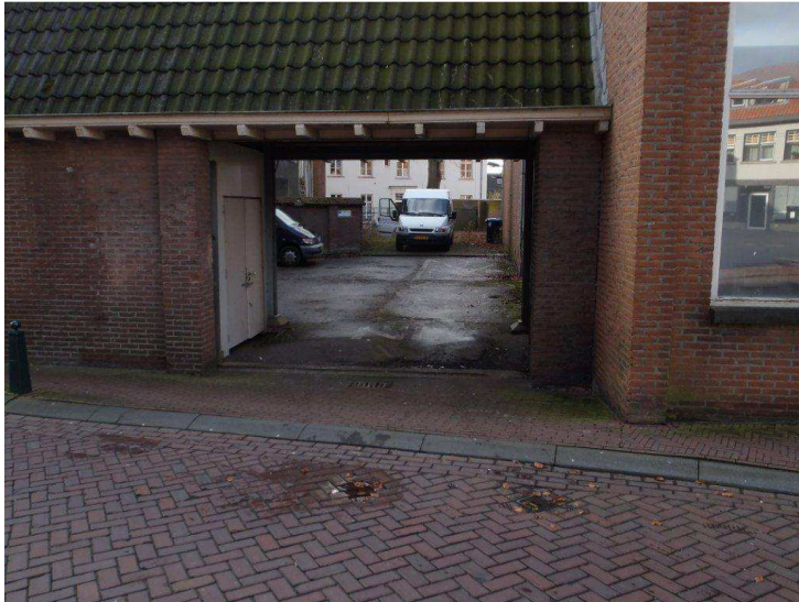
foto 1 asfaltverharding Paardenmarkt 2 Hulst (zuidelijke richting)
