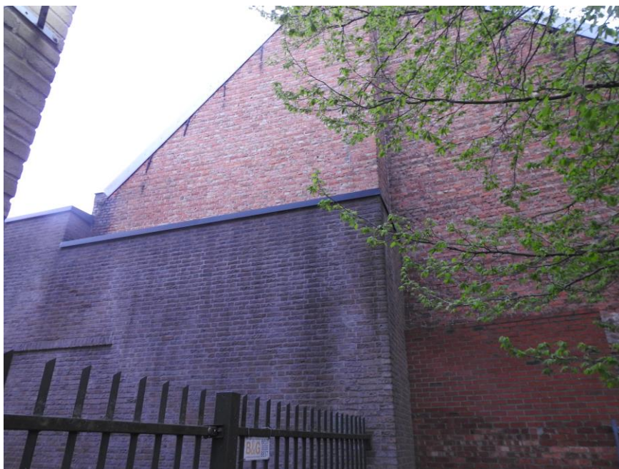
Foto 5. Te slopen voormalige bioscoop.
