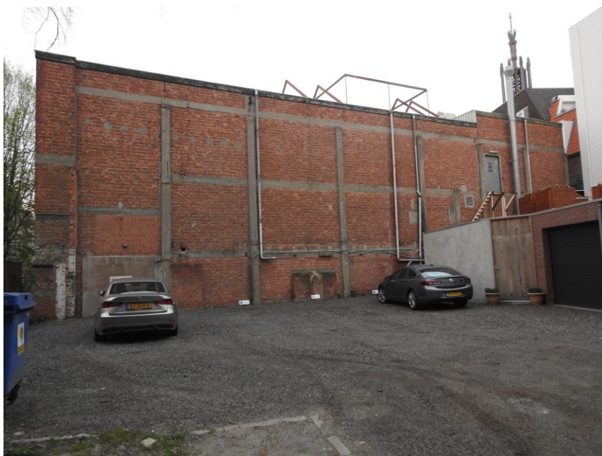
Foto 6. Te slopen voormalige bioscoop.
