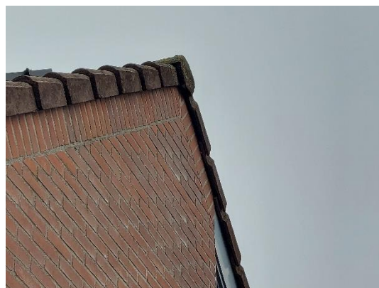
Figuur 5.3 Ruimte onder nokpan.
