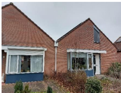
Figuur 2.4 De voorzijde van de woningen.
