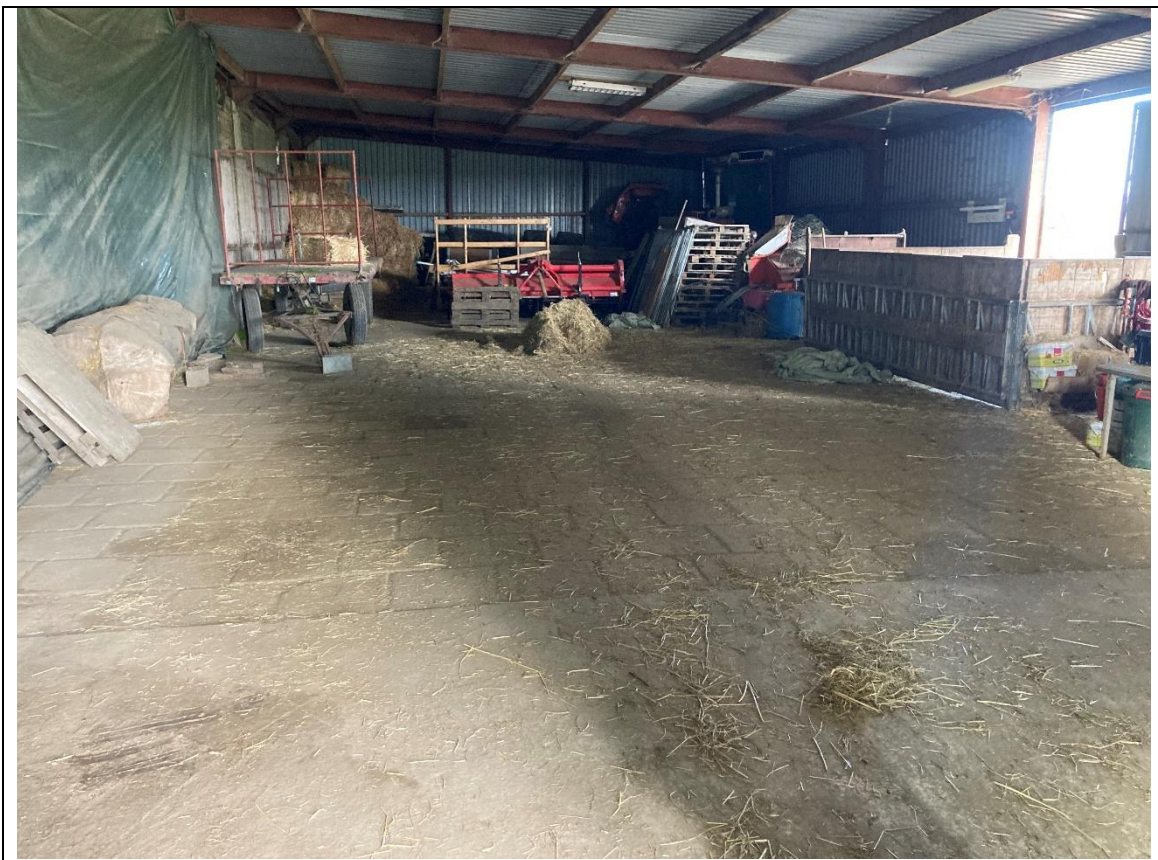
Foto 7: binnen de overkapping van de schuur
