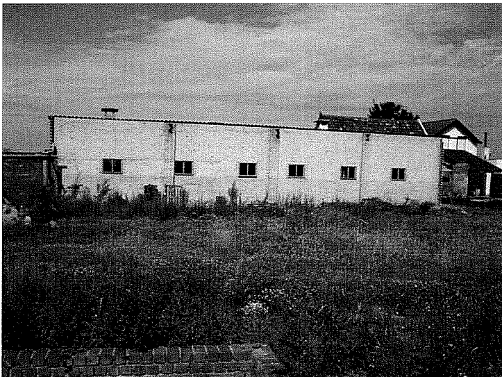
foto 2 te slopen bebouwing, in deze voormalige varkenschuur zijn zes nesten van de Boerenwaluw gesitueerd (westelijke richting)
