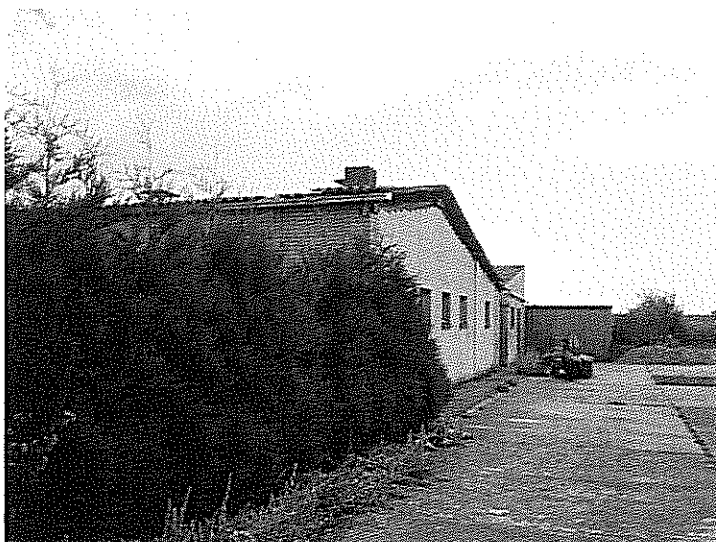
foto 5 Links de te slopen bebouwing met een coniferenhaag op de perceelgrens. Op de voorgond de ter- reinverharding van het naast gelegen erf. vanuit westelijke richting gezien
