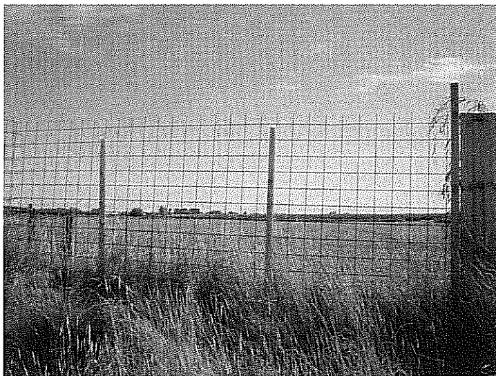
foto 8 Afrastering op de perceelsgrenzen door middel van betonnetten met daarachter landbouwpercelen. vanuit zuidwestelijke richting gezien
