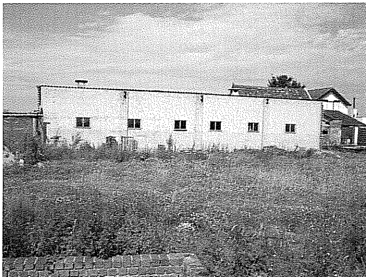
foto 4 Te slopen bebouwing. vanuit oostelijke richting gezien
