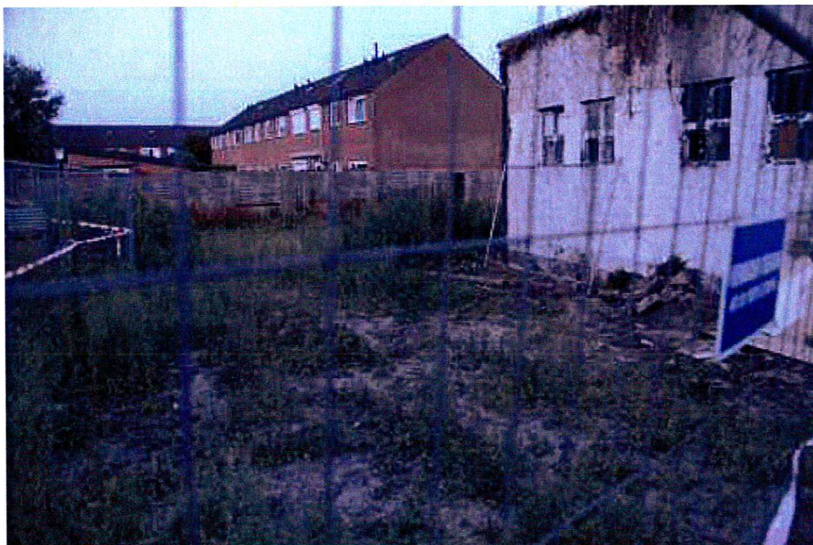
Foto 1. Te slopen garage.
