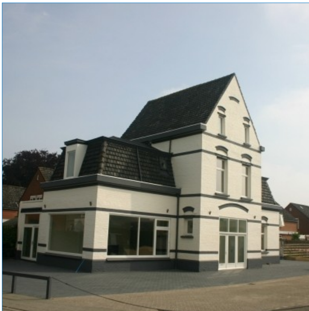
Afbeelding 2. Aanzicht voormalige bedrijfswoning na renovatie (bron: de Pagter Vastgoed)
