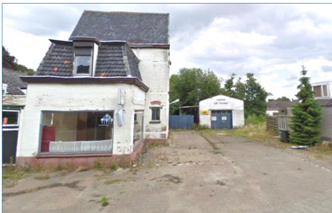
Foto 1. Foto vooraanzicht perceel na beëindiging bedrijfsactiviteiten. Bron: Google Streetview
