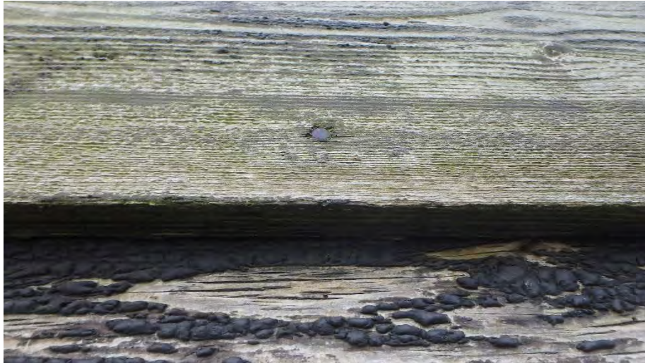
foto 4: resten van teer of 'teerdruppels' zijn goed zichtbaar (- richting)
