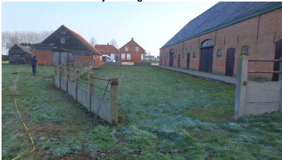
foto 1: zicht op de onderzoekslocatie (zuidoostelijke richting)
