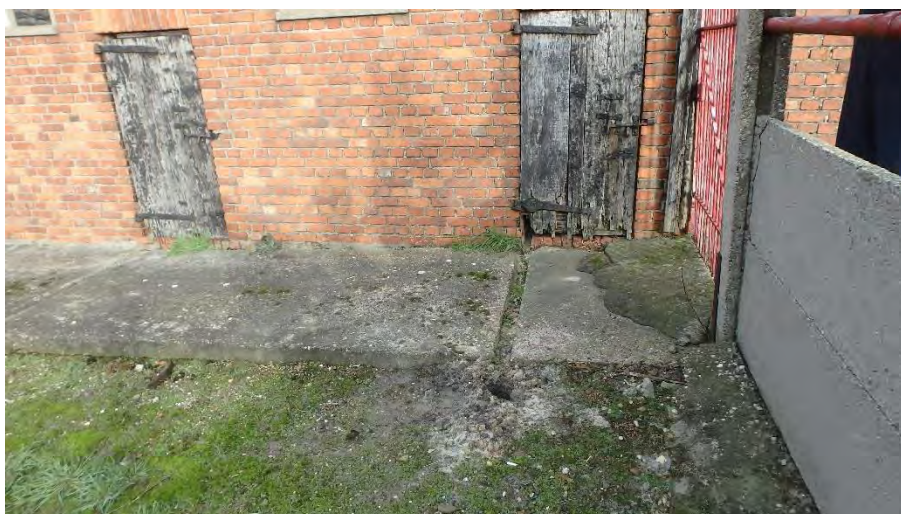
foto 3: boring 9 van vorig onderzoek, vertoonde sterke concentraties door verontreinigde afwatering afkomstig van de behandelde deur en verplaatst op zijn beurt via het gootje naar de bodem toe. (noordoostelijke richting)
