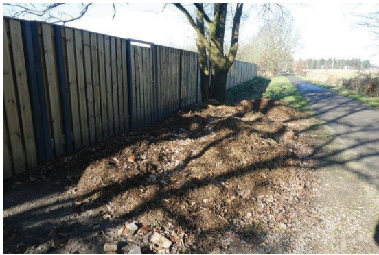
Zicht vanaf het fietspad aan de oostzijde.
