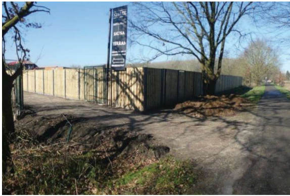
Zicht vanaf het fietspad op de schutting aan zuid en oostzijde.
