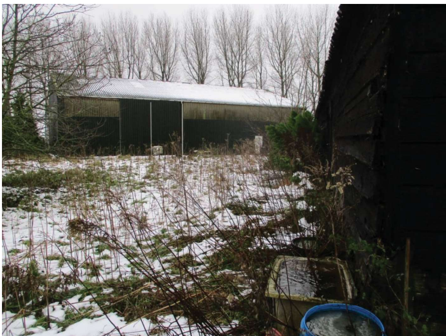
Onverhard terrein oostzijde achter schuur
