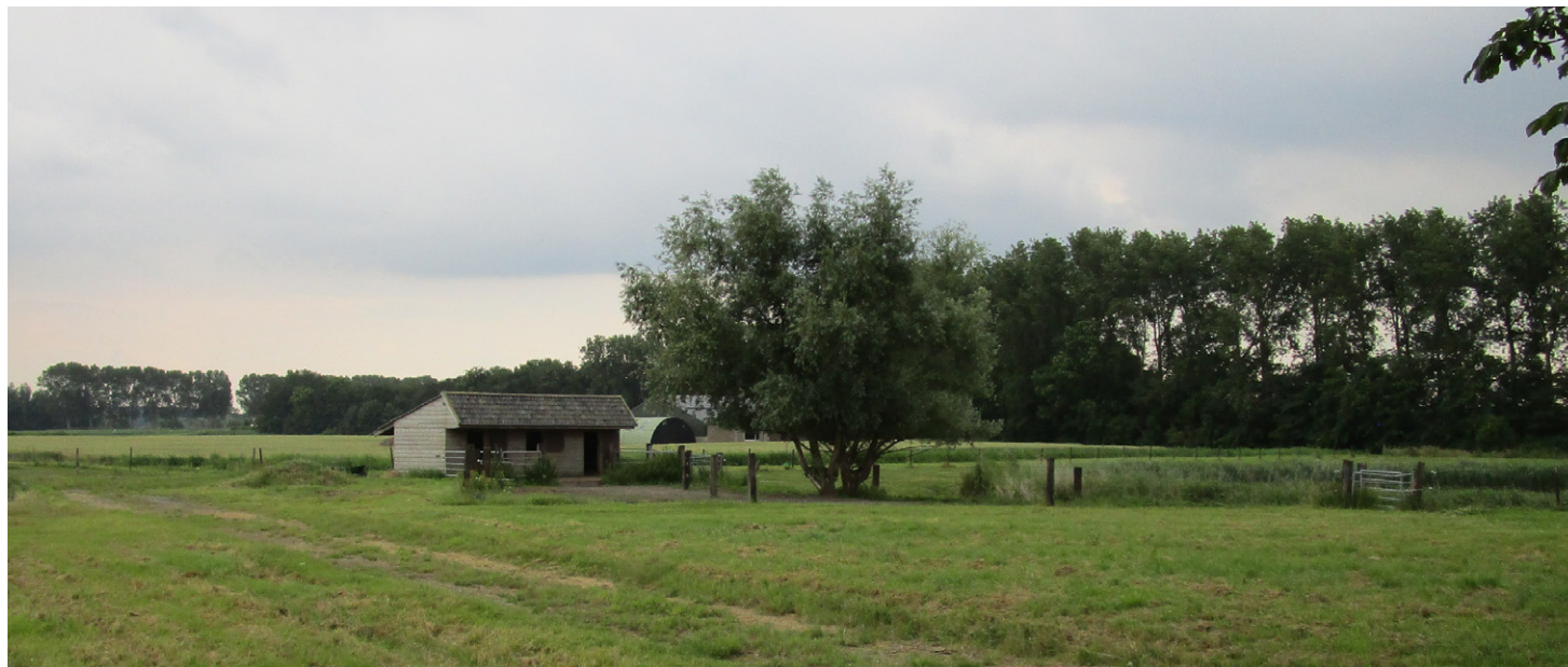
Bestaande paardenstal met uitzicht op het omliggende landschap.
