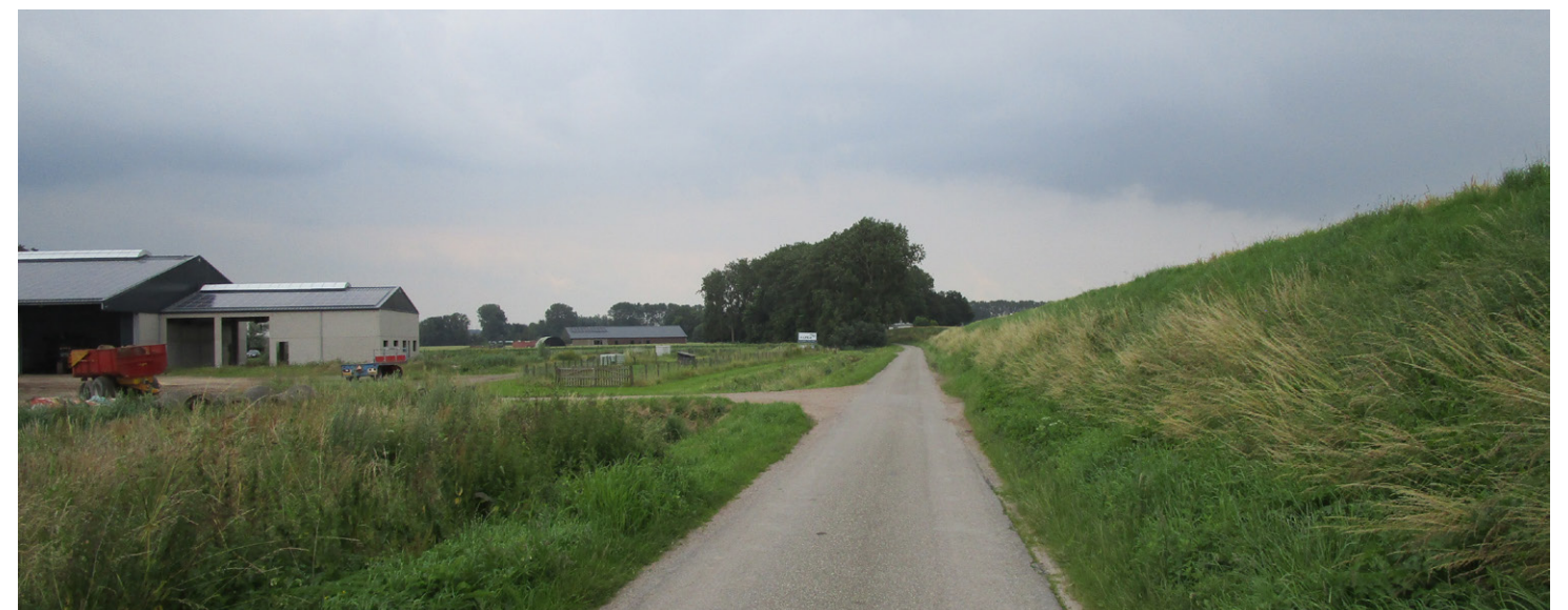
Zicht over de weg met rechts het dijklichaam en aan de linkerkzijde de bestaande loods.
