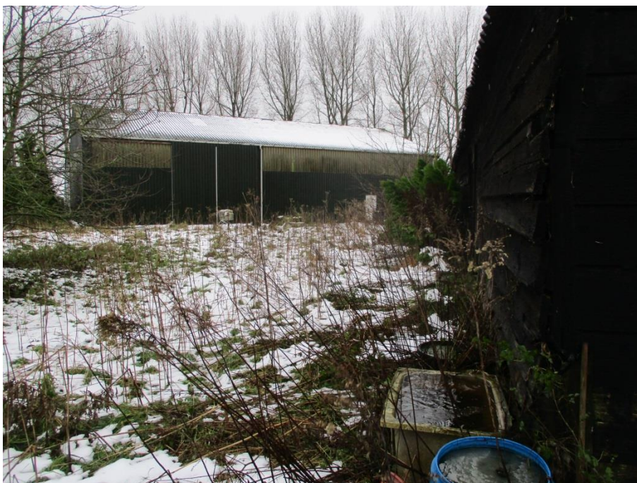
Onverhard terrein oostzijde achter schuur
