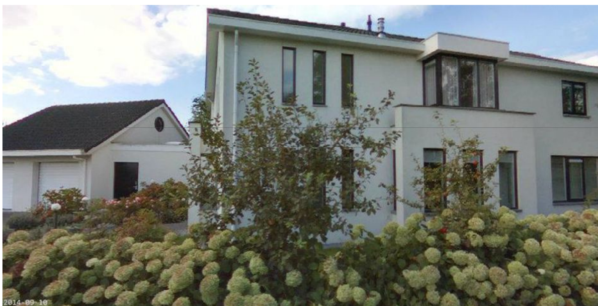
Figuur 1 | Huidige bedrijfswoning met bijgebouw
