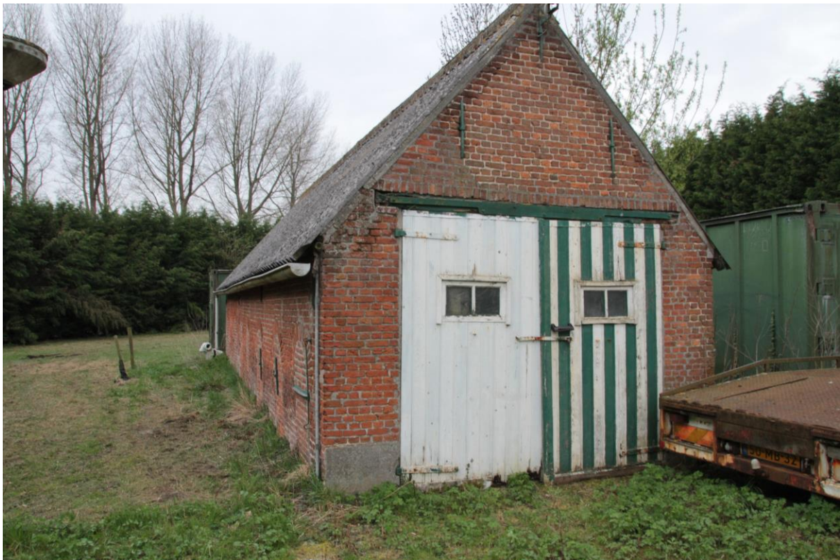
Foto 1. Te slopen gebouw (1).
