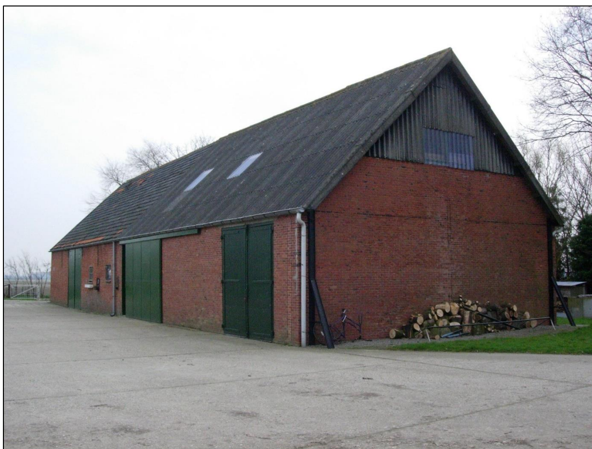
afbeelding 2, schuur Grootmoedersdijk 5, Kuitaart
