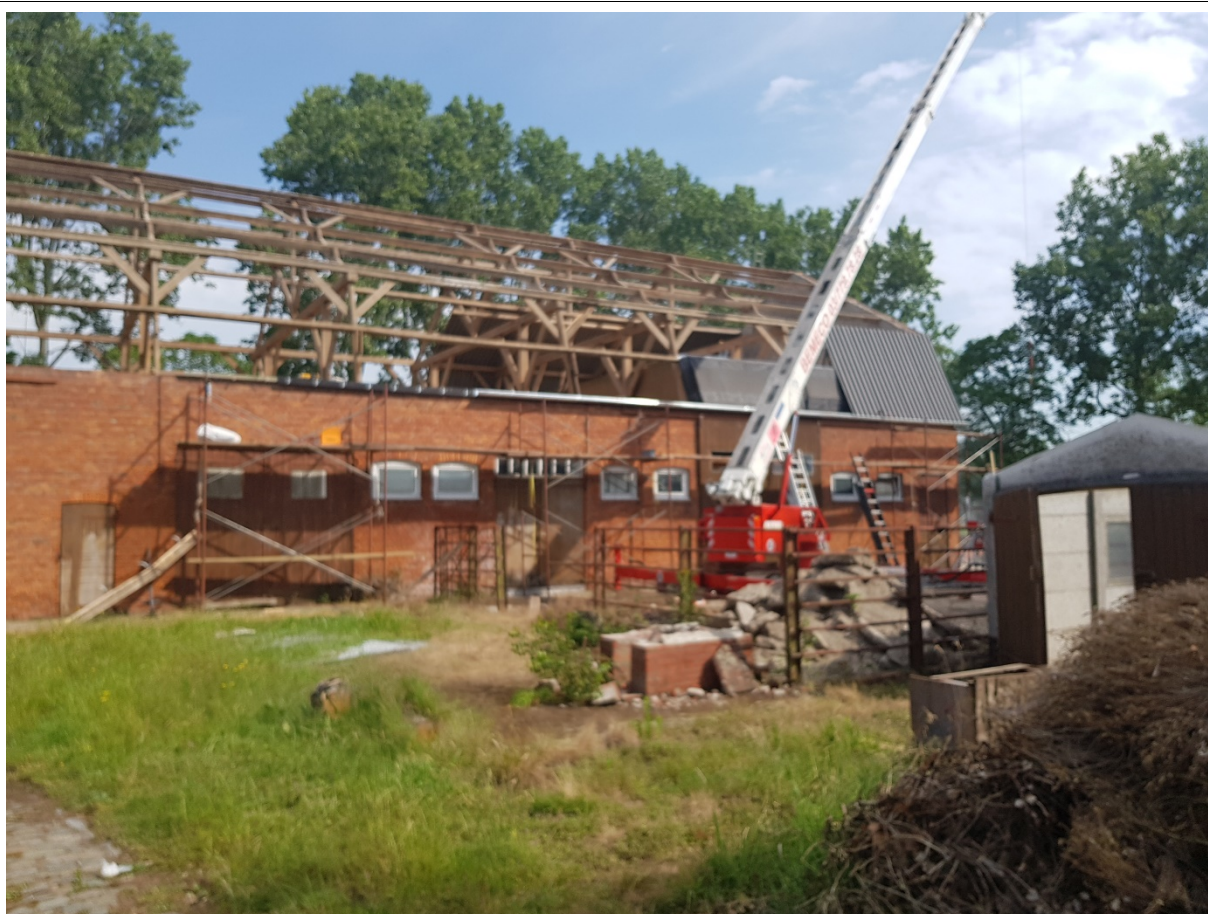
Figuur 6. Renovatie zomer 2019
