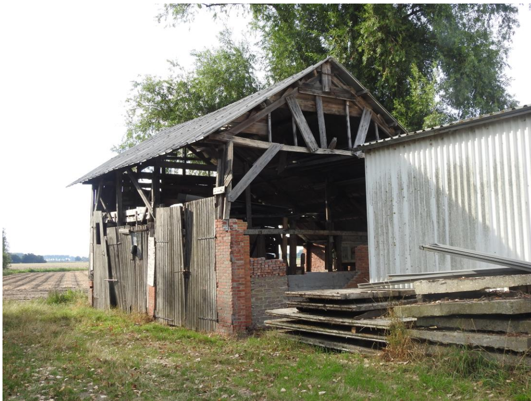
Foto 4. Object 3. Te slopen bebouwing.
