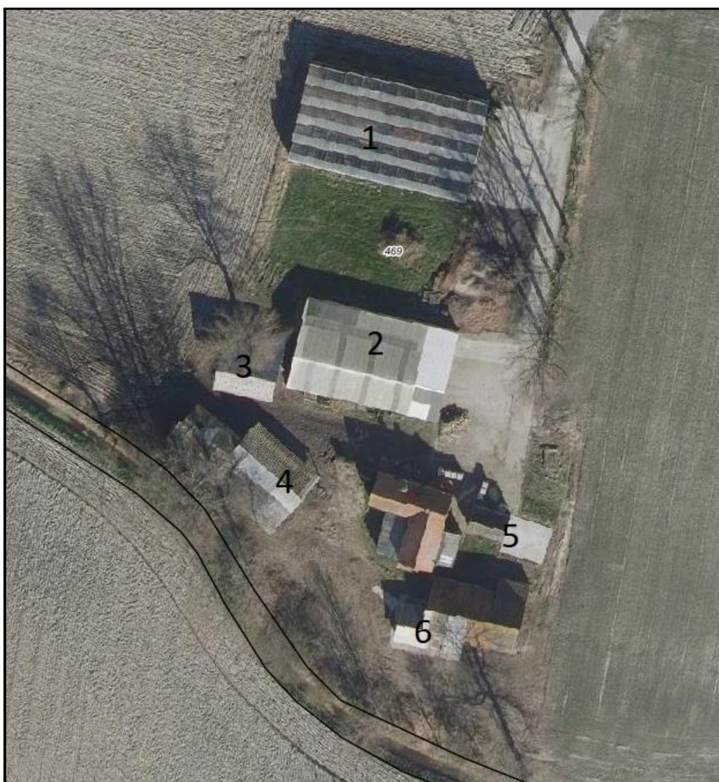
Figuur 2: Luchtfoto met aanwezige bedrijfsgebouwen
