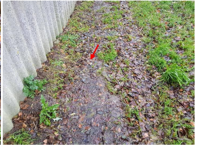
Foto 71 | Foto voor bron Golfplaat (verontreiniging)
