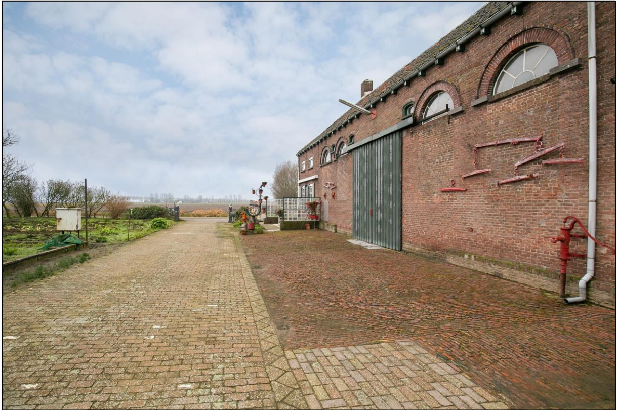
figuur 6.1: Zuidgevel te handhaven bedrijfswoning, de oude schoolramen zijn nog zichtbaar
