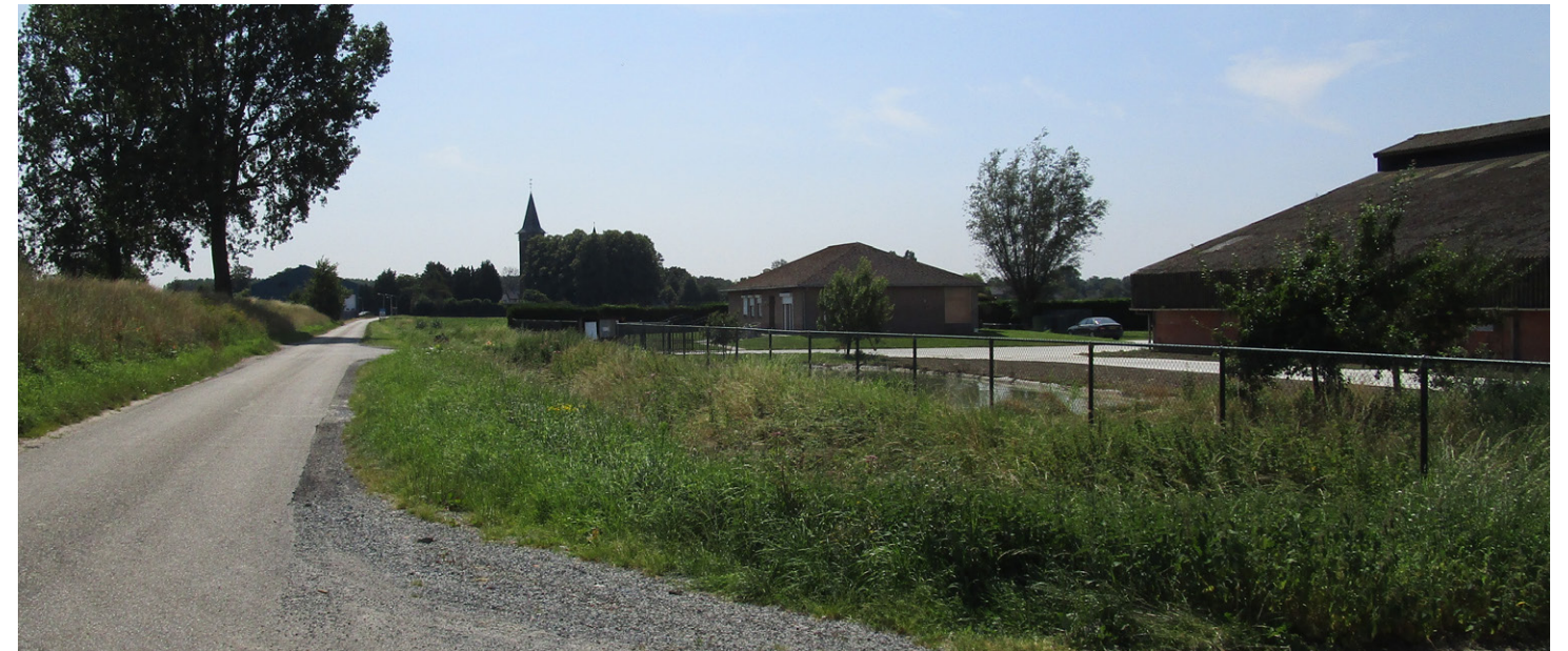
Zicht langs de Oud Ferdinandusdijk in zuidelijke richting naar de kern Heikant.
