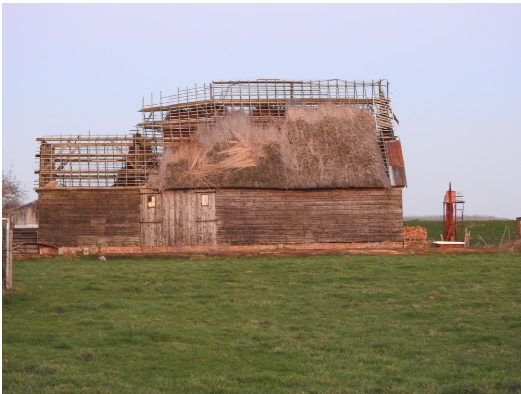
Foto 1. Te slopen bebouwing.
