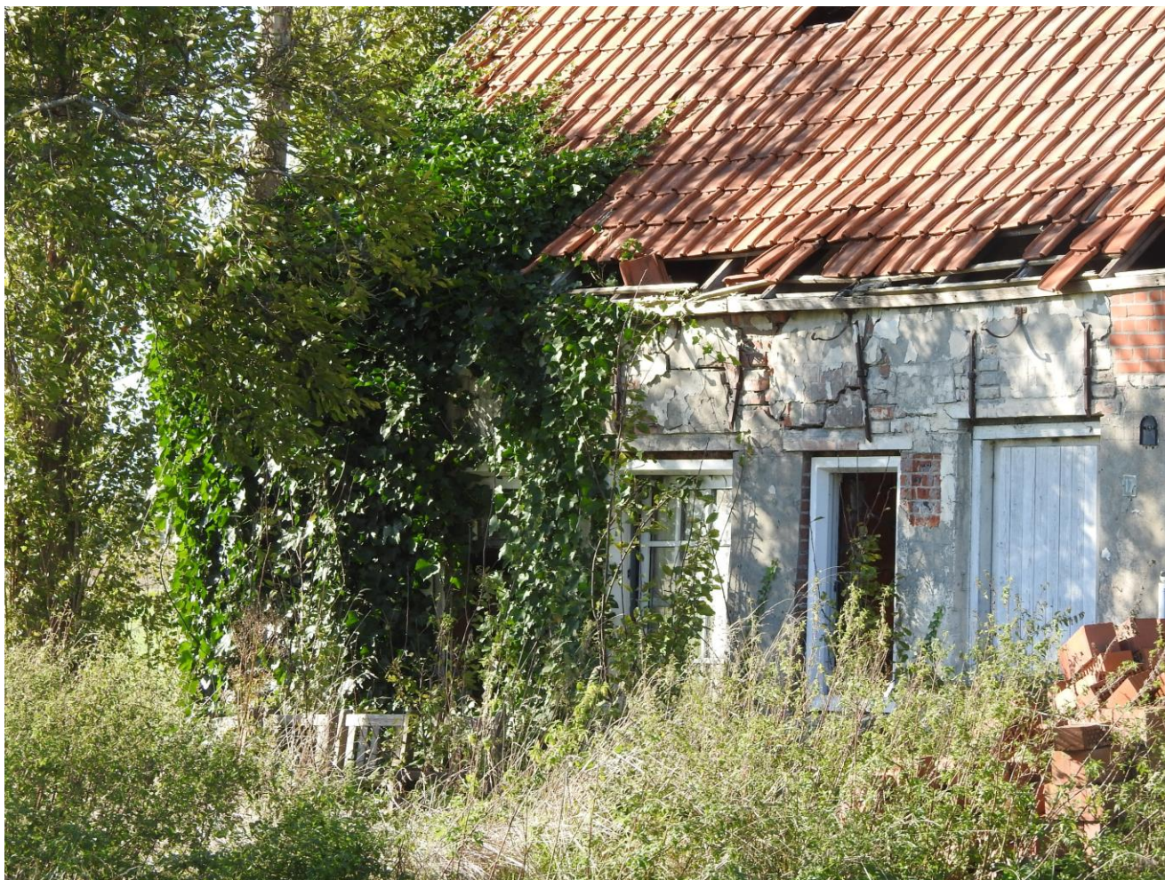
Foto 2. Te slopen woonhuis.
