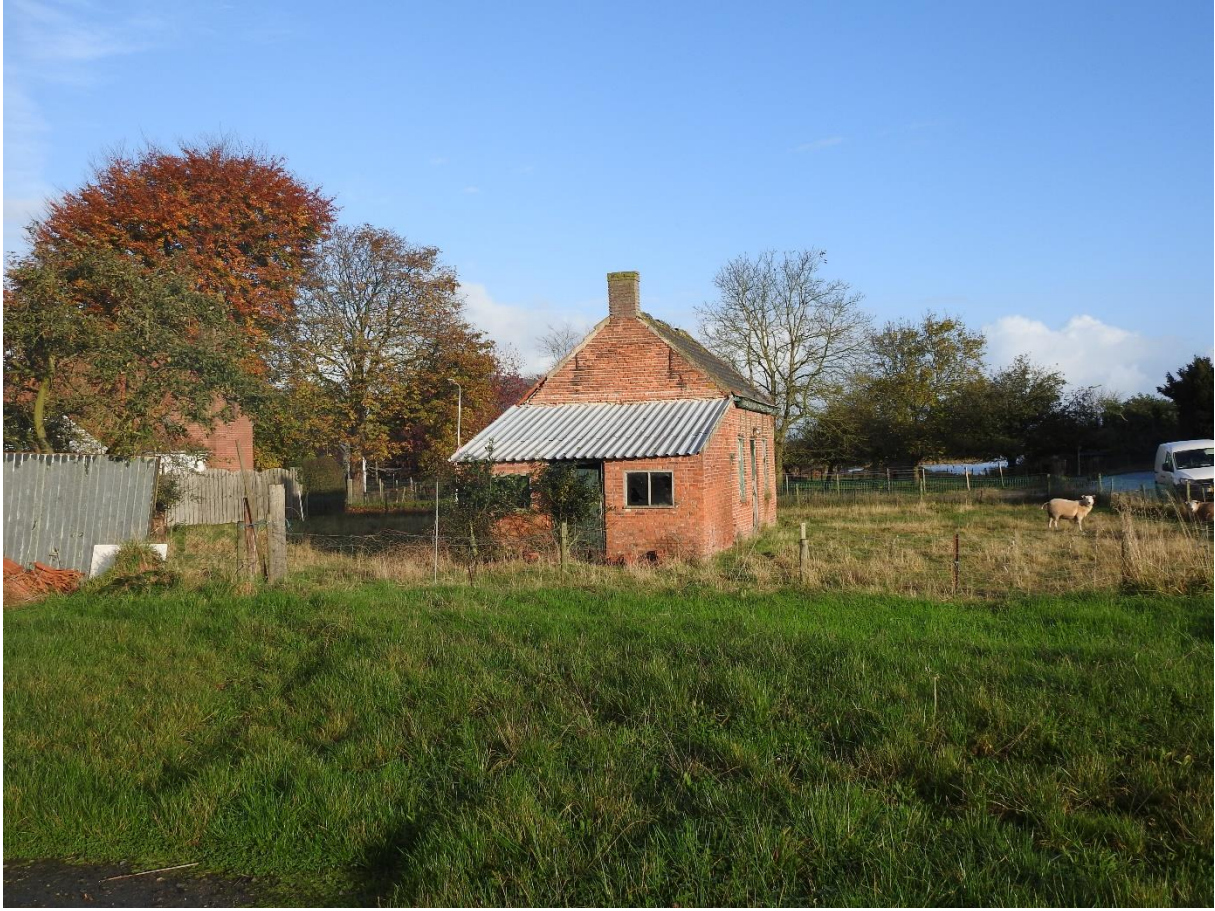
Foto 2. Te slopen bebouwing (vervallen huis).
