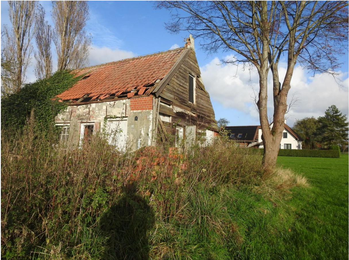
Foto 1. Te slopen bebouwing.
