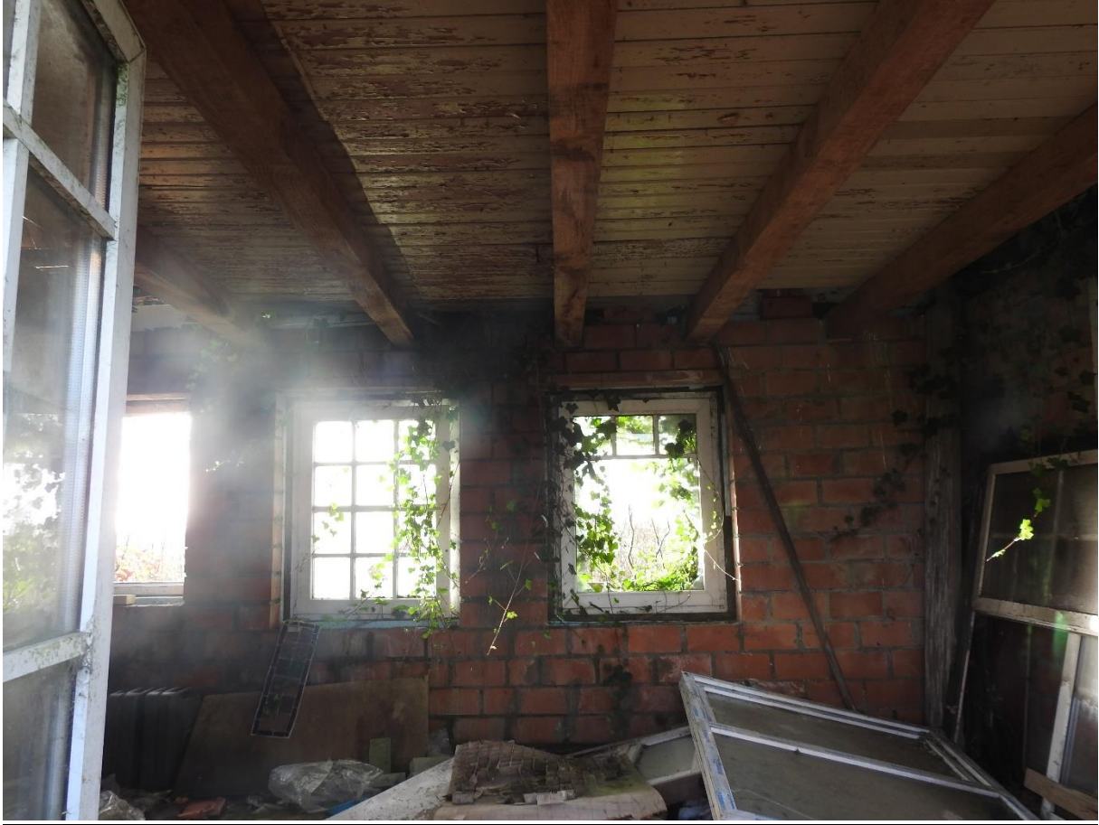
Foto 2. Te slopen bebouwing.
