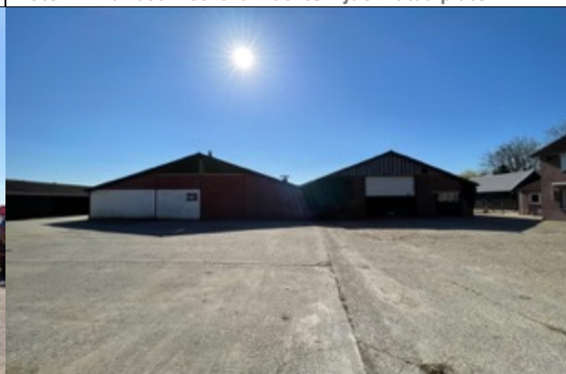
Foto 24: Voorzijde te slopen schuren 1 en 2
