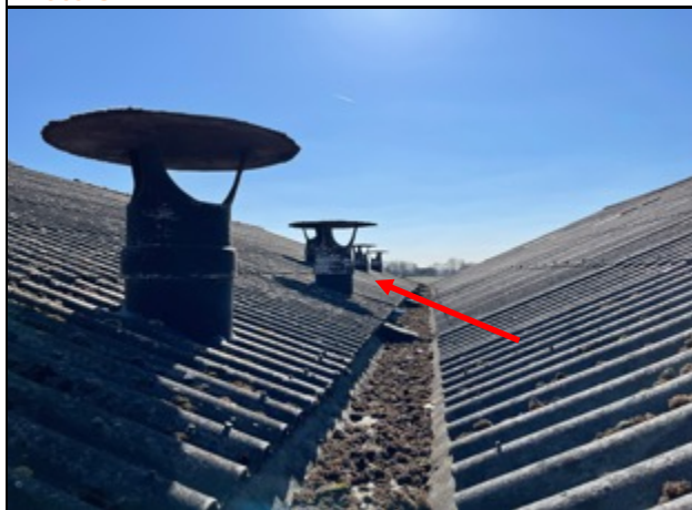
Foto 1: Ventilatiekappen dak schuur 2
