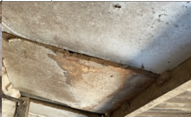
Foto 12: Isolatieplaten onder golfplaten dak
