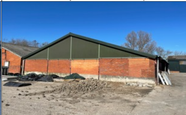
Foto 6: Te slopen schuur 2 achtergevel met gaasnetten
