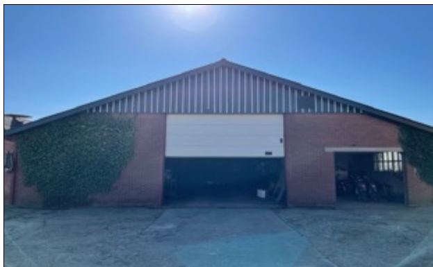
Foto 1: Te slopen schuur 1
