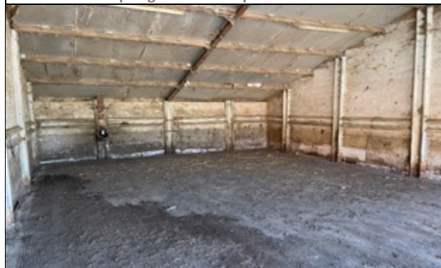
Foto 13: Leeg gedeelte met betonvloer schuur 3
