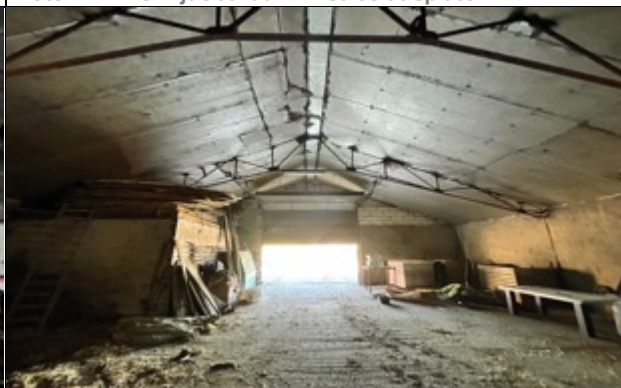
Foto 4: Binnen-voorzijde schuur 1 met isolatieplaten
