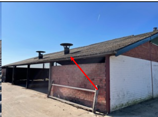
Foto 2: Ventilatiekappen dak schuur 2
