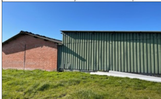
Foto 21: Te slopen schuur met aanbouw aan achterzijde
