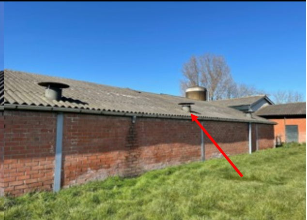
Foto 2: Ventilatiekappen dak schuur 3
