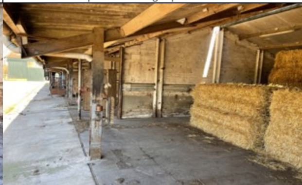
Foto 14: Gedeelte met stro en betonvloer schuur 3
