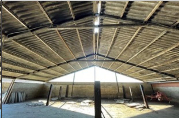
Foto 8: Binnenzijde schuur 2 niet geïsoleerd betonvloer
