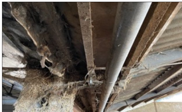
Foto 9: Onderzijde kilgoot en HWA pvc
