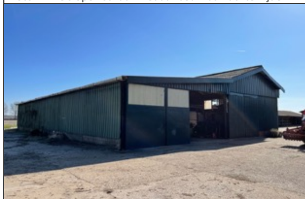
Foto 23: Te slopen schuur 4 met damwandprofielplaten
