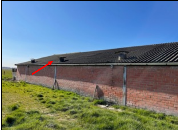
Foto 1: Ventilatiekappen dak schuur 3
