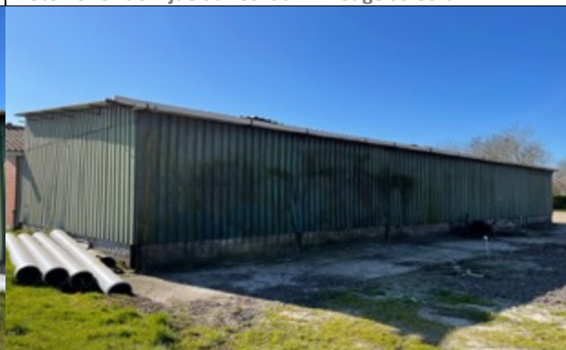
Foto 22: Aanbouw schuur 4 achterzijde metaalplaten
