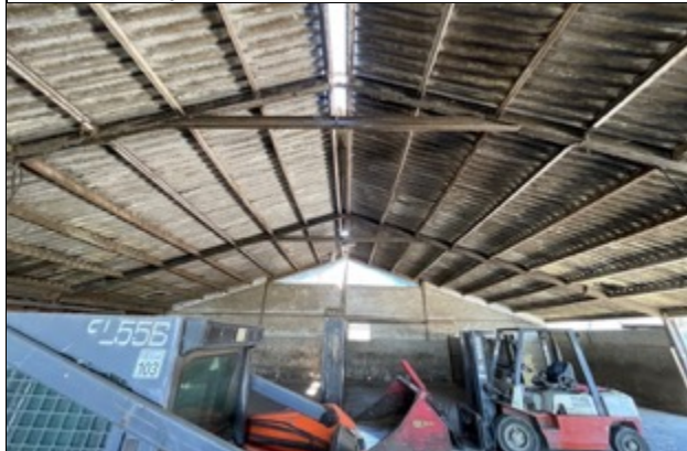
Foto 7: Binnenzijde schuur 2 niet geïsoleerd betonvloer
