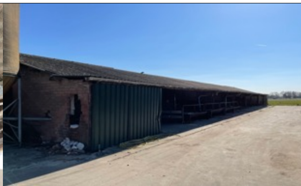
Foto 10: Te slopen schuur 3
