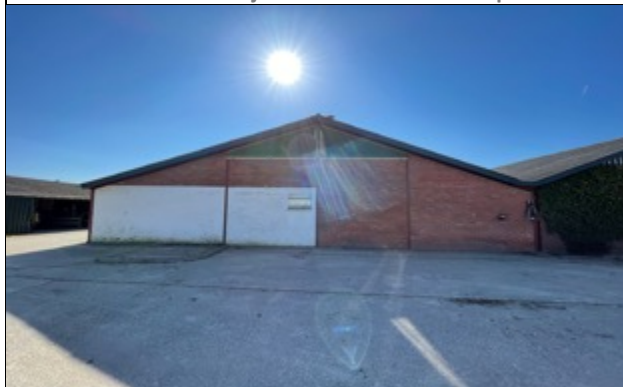
Foto 5: Te slopen schuur 2
