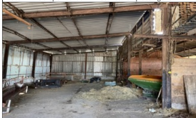
Foto 19: Aanbouw achterzijde metaalconstructie-platen
