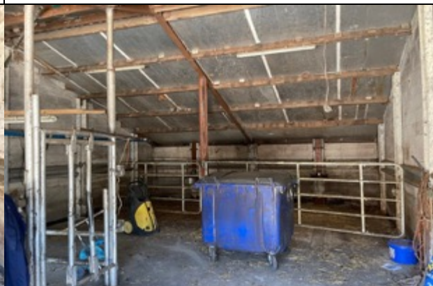
Foto 16: Leeg gedeelte met betonvloer schuur 3
