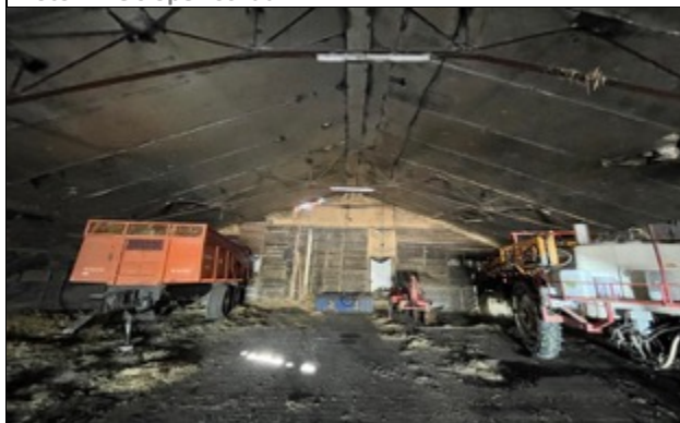
Foto 3: Binnen-achterzijde schuur 1 met isolatieplaten
