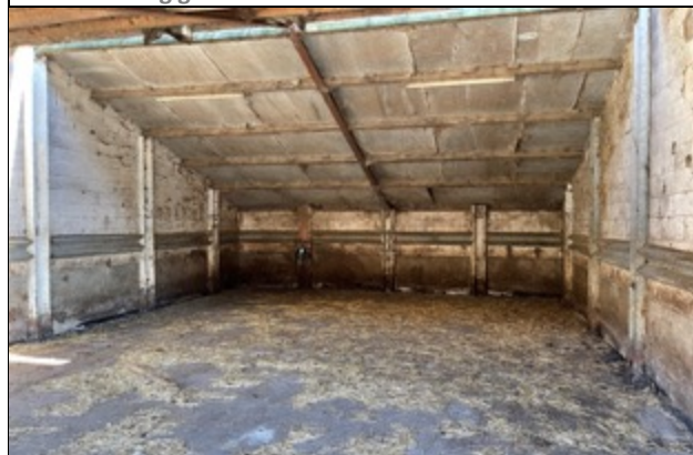
Foto 15: Leeg gedeelte met betonvloer schuur 3
