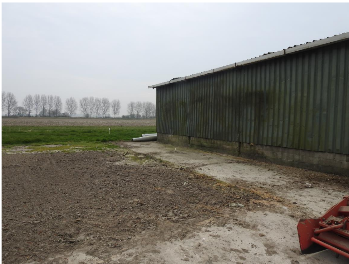
Foto 4. Kierende gevelbeplating.
