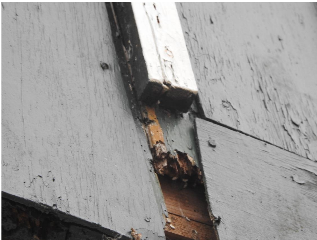
Foto 4. Kierende gevelbeplating.
