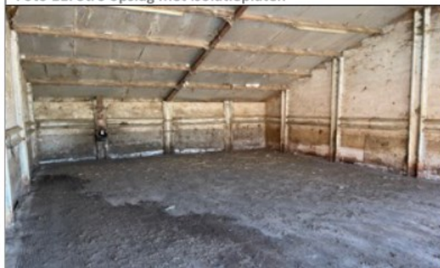
Foto 13: Leeg gedeelte met betonvloer schuur 3
