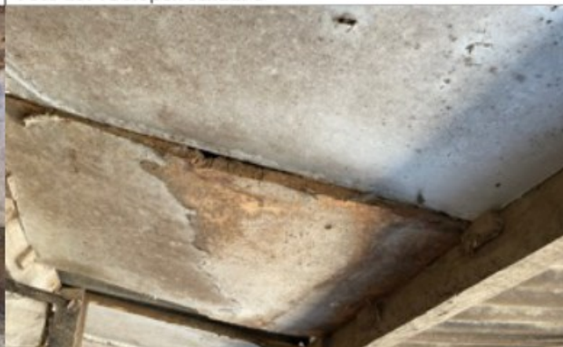
Foto 12: Isolatieplaten onder golfplaten dak
