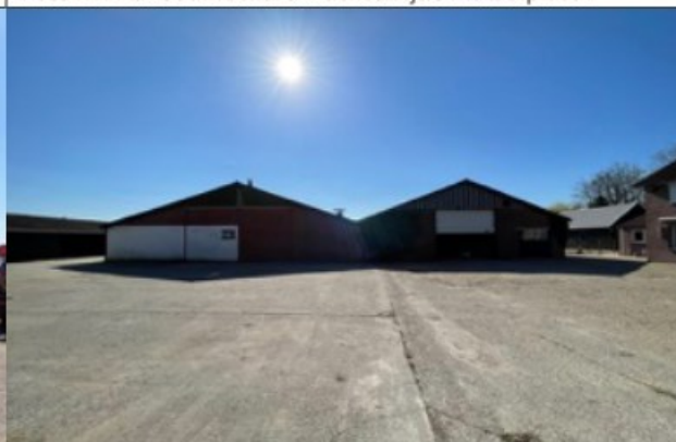
Foto 24: Voorzijde te slopen schuren 1 en 2
