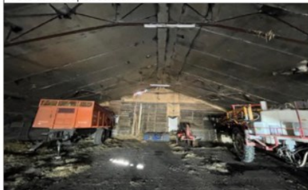
Foto 3: Binnen-achterzijde schuur 1 met isolatieplaten
