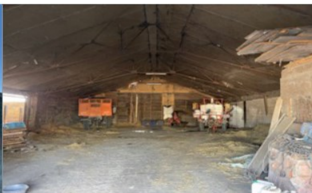
Foto 2: Binnenzijde schuur 1 met isolatieplaten
