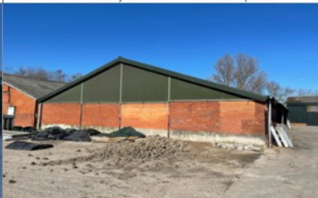
Foto 6: Te slopen schuur 2 achtergevel met gaasnetten
