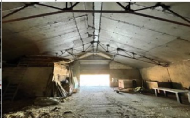
Foto 4: Binnen-voorzijde schuur 1 met isolatieplaten
