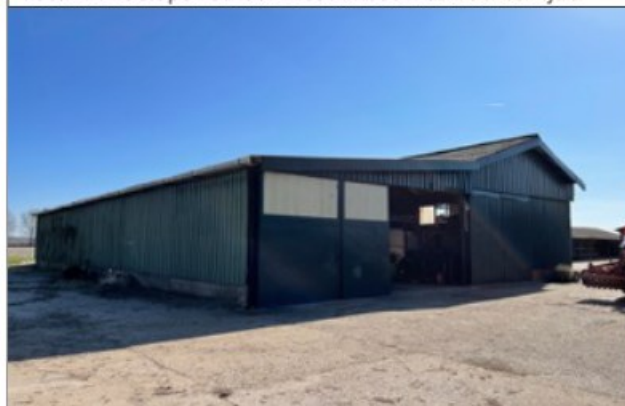
Foto 23: Te slopen schuur 4 met damwandprofielplaten
