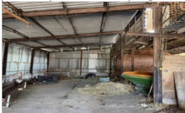
Foto 19: Aanbouw achterzijde metaalconstructie-platen
