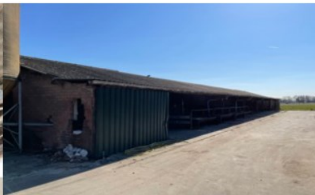
Foto 10: Te slopen schuur 3
