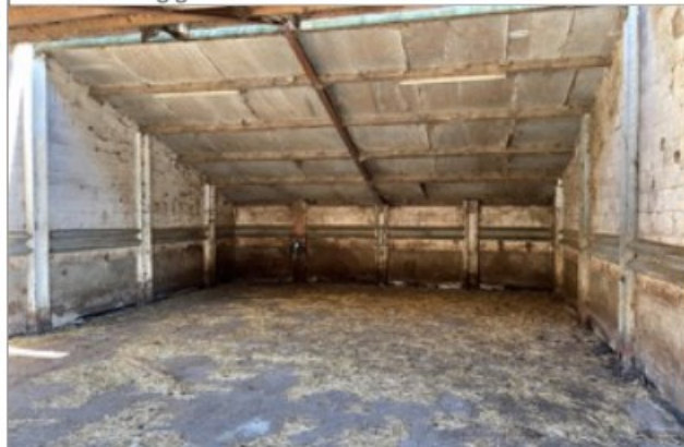
Foto 15: Leeg gedeelte met betonvloer schuur 3
