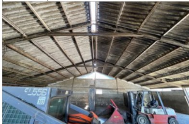
Foto 7: Binnenzijde schuur 2 niet geïsoleerd betonvloer
