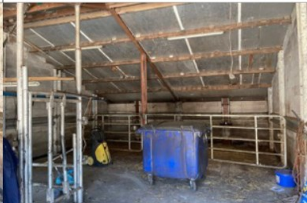
Foto 16: Leeg gedeelte met betonvloer schuur 3
