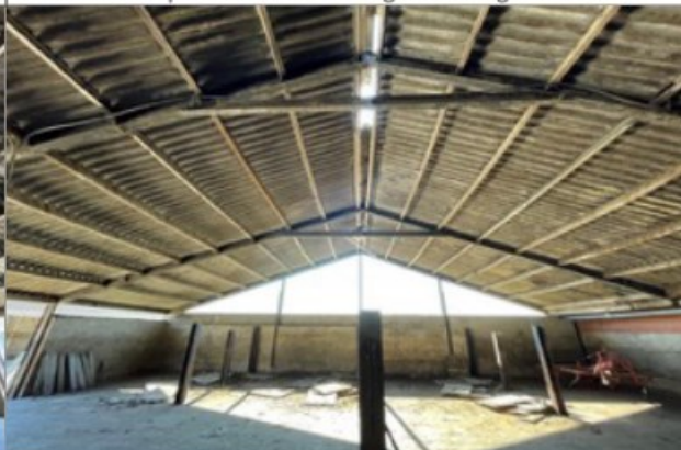
Foto 8: Binnenzijde schuur 2 niet geïsoleerd betonvloer
