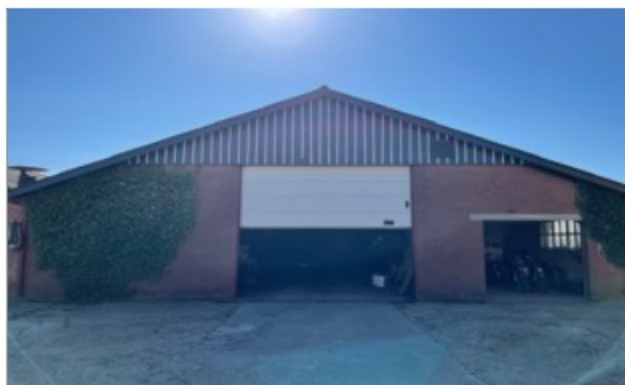
Foto 1: Te slopen schuur 1
