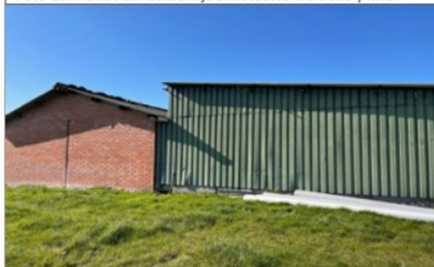
Foto 21: Te slopen schuur met aanbouw aan achterzijde
