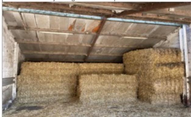
Foto 11: Stro opslag met isolatieplaten
