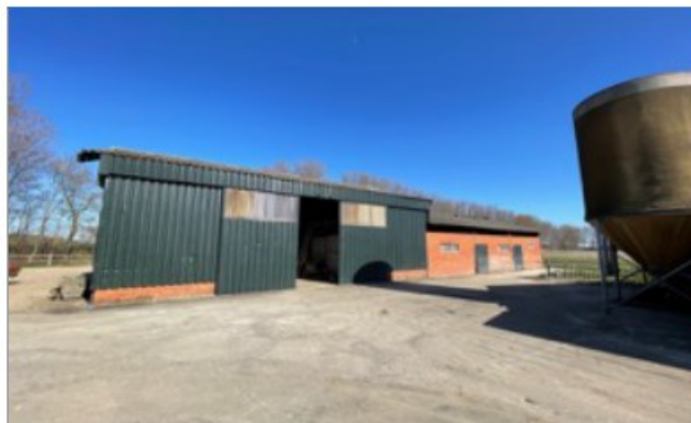
Foto 17: Te slopen schuur 4 met metalen platen gevel
