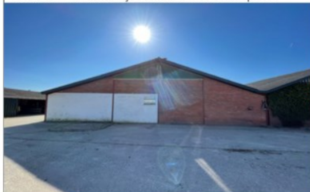
Foto 5: Te slopen schuur 2
