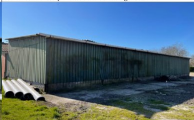
Foto 22: Aanbouw schuur 4 achterzijde metaalplaten
